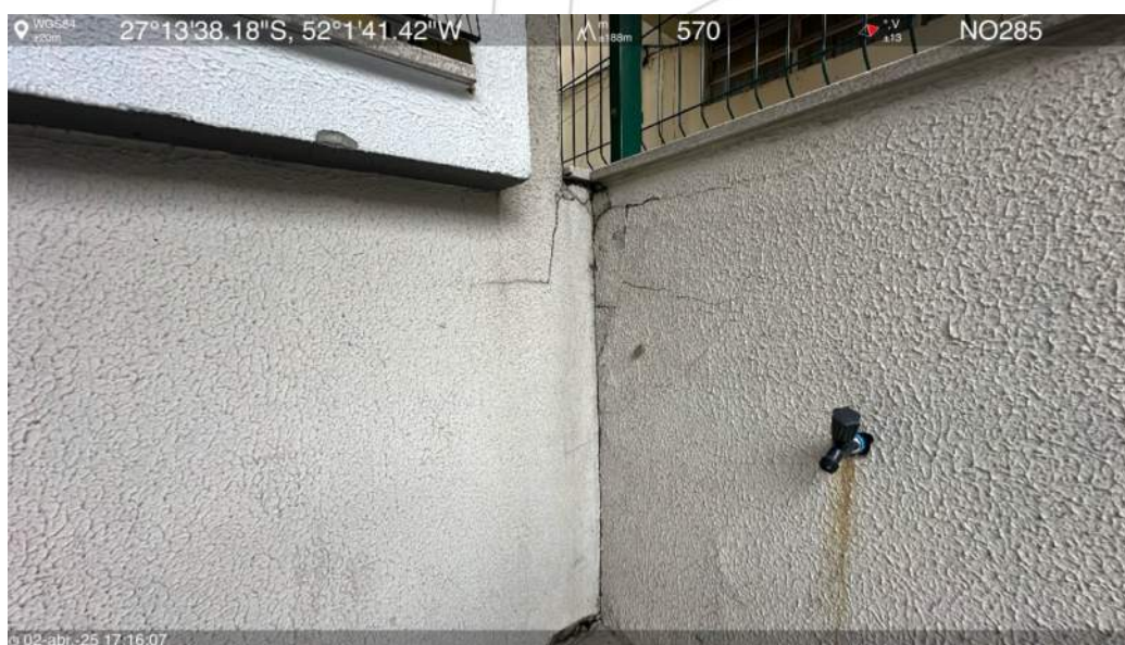
Térreo leste - Parquinho (Detalhe)
