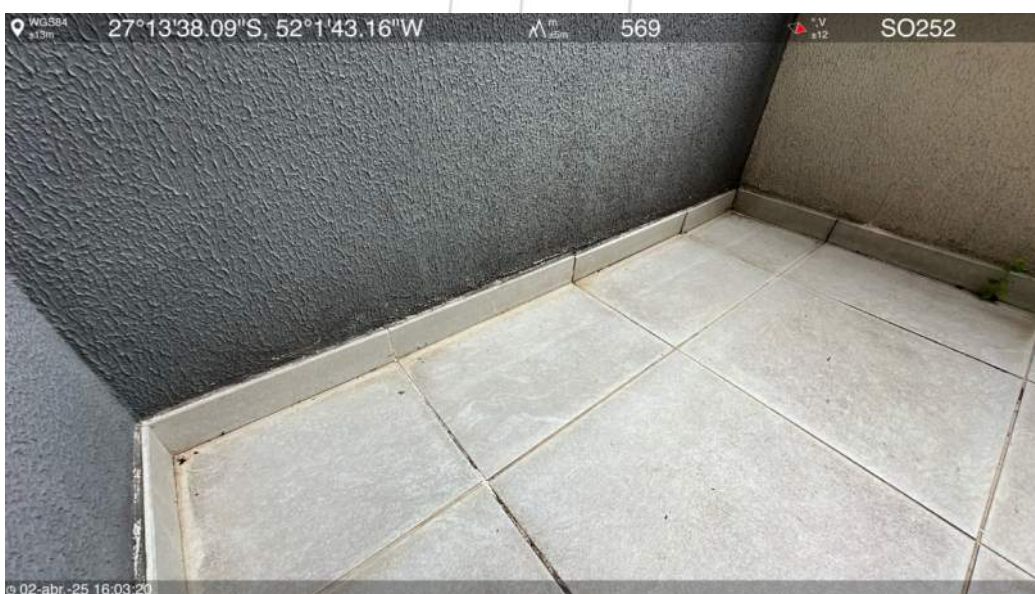
Laje intermediária da biblioteca
