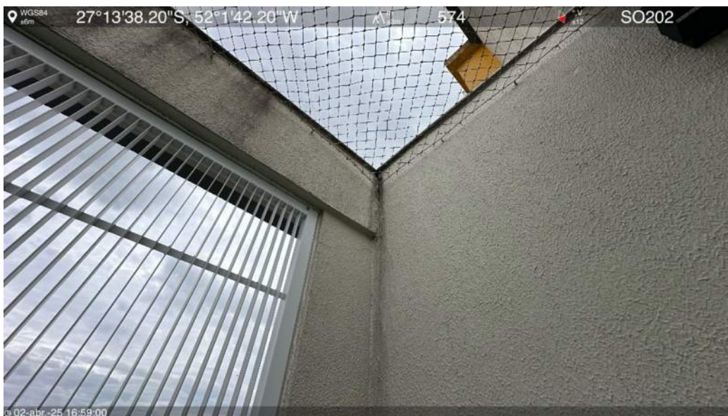
Laje intermediária do 7º pavimento
