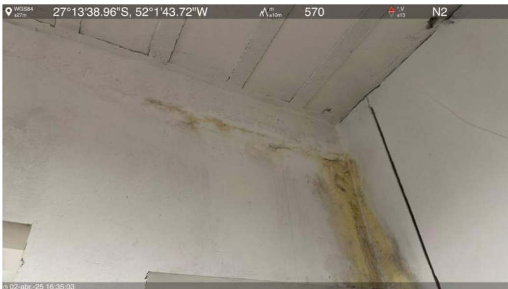
Manutenção (abaixo da laje do 2° pavimento)
