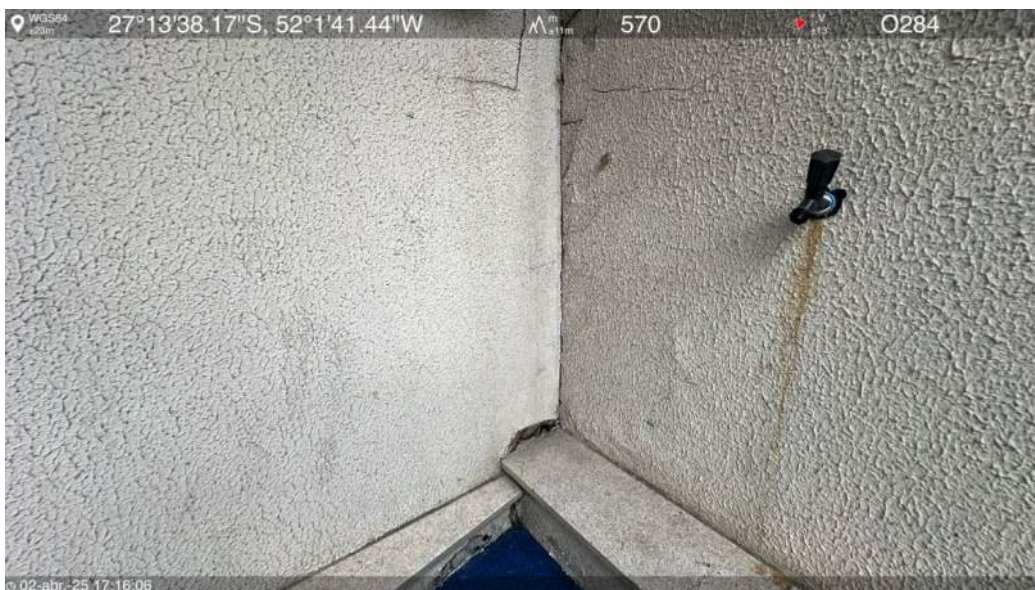
Térreo leste - Parquinho (Detalhe)
