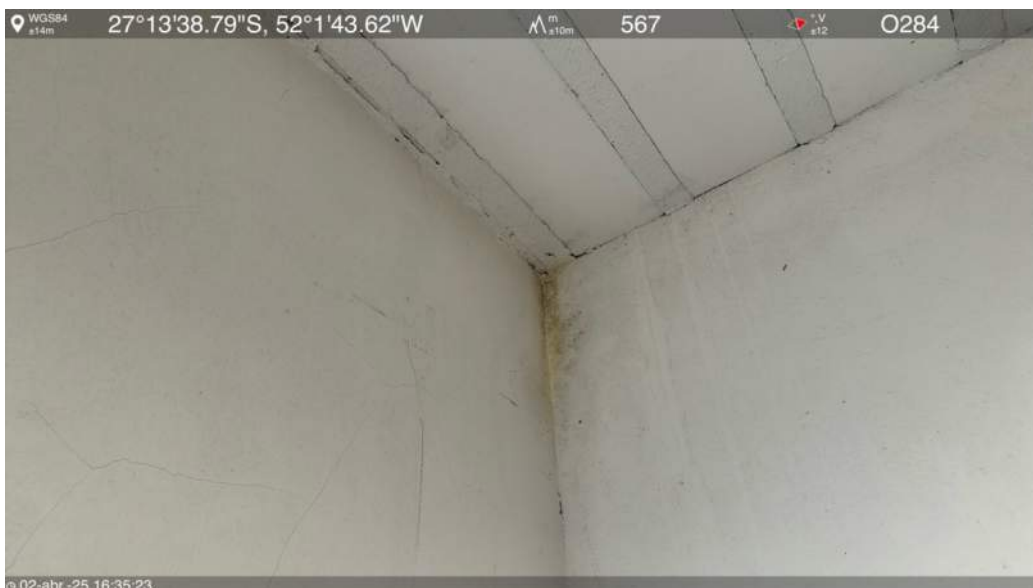
Manutenção (abaixo da laje do 2º pavimento)
