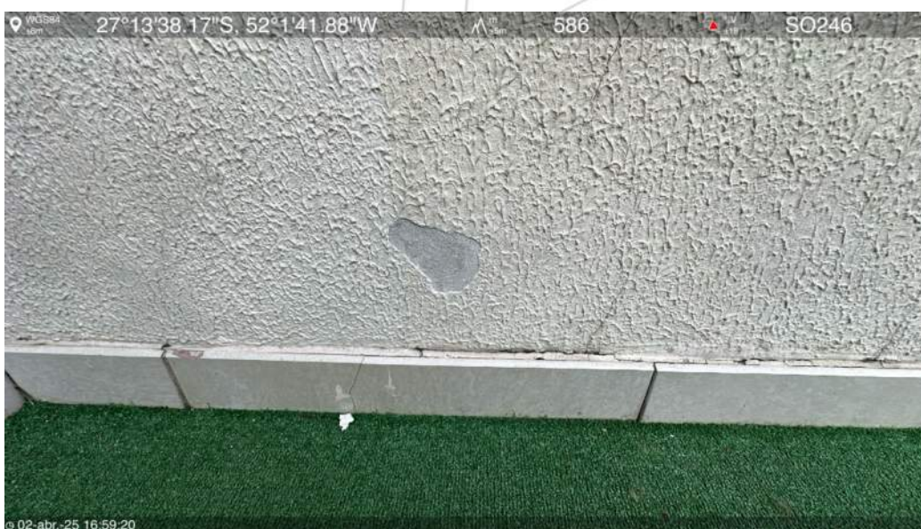
Laje intermediária do 7º pavimento
