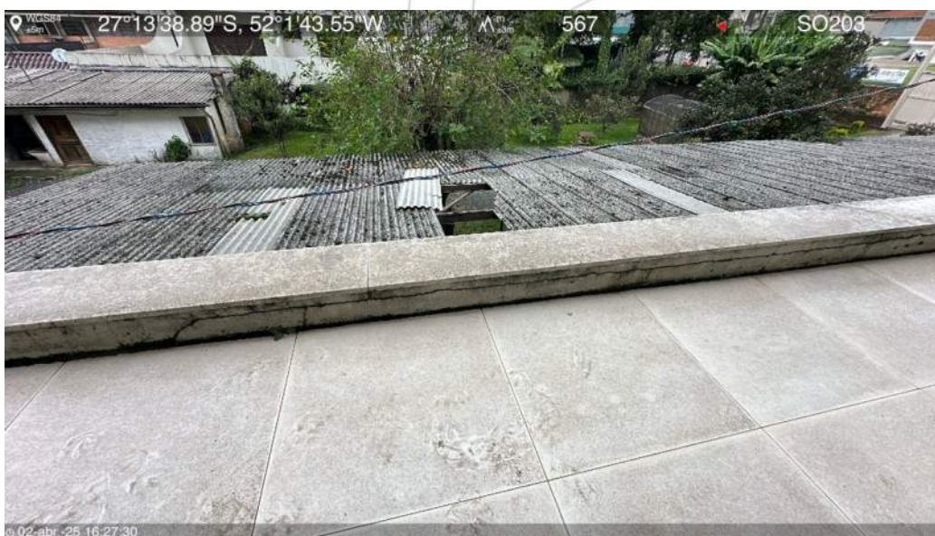
Laje intermediária do 2º pavimento
