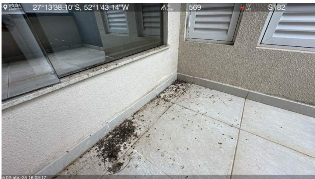
Laje intermediária da biblioteca
