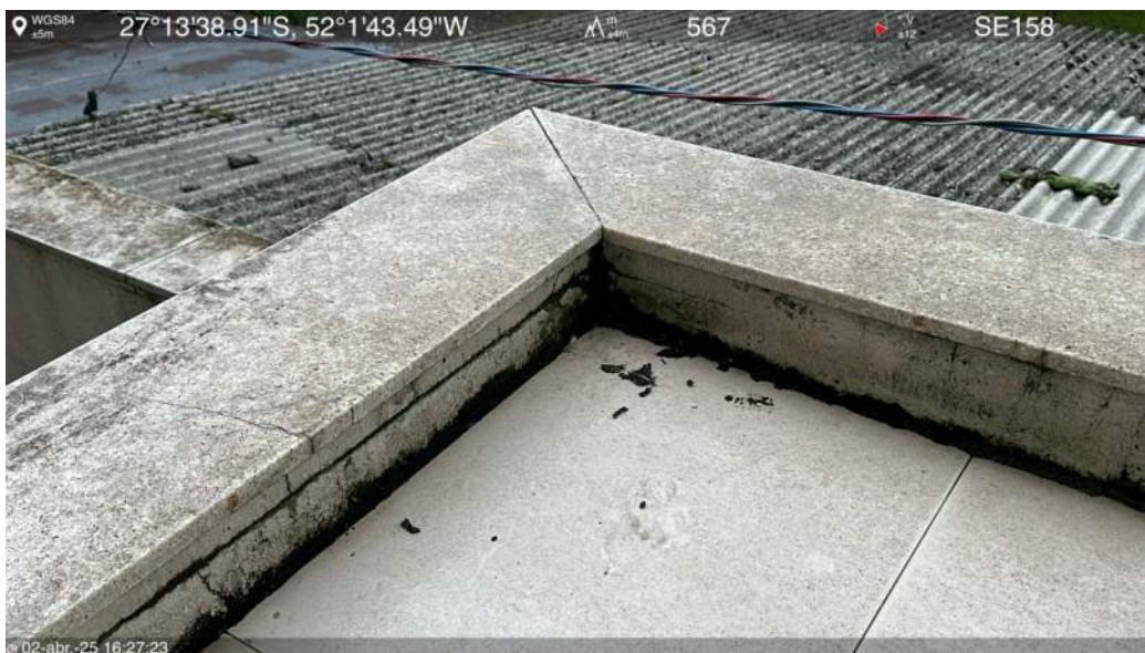
Laje intermediária do 2º pavimento
