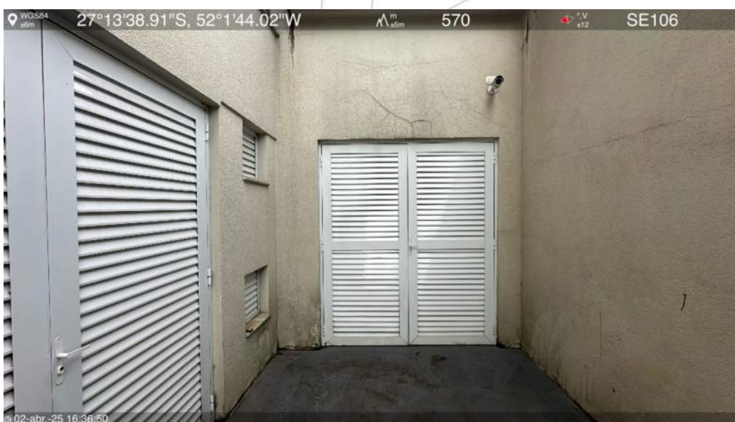
Rampa de acesso oeste
