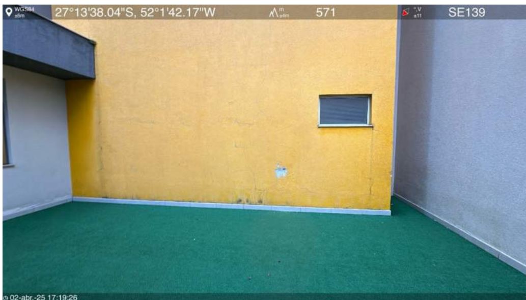
Fachada norte (vão)
