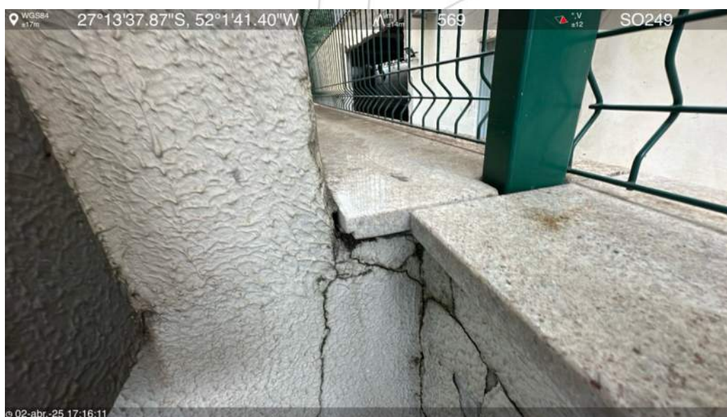
Térreo leste - Parquinho (Detalhe)
