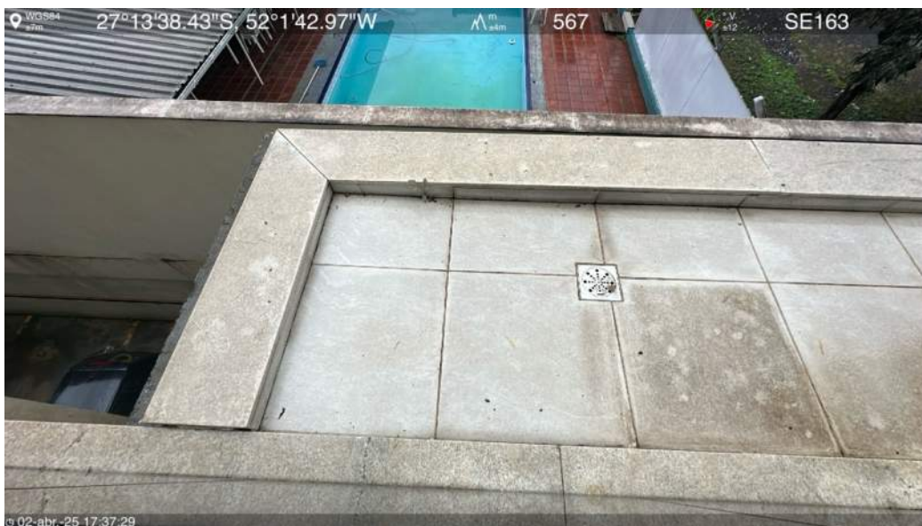
Laje intermediária (Recepção)
