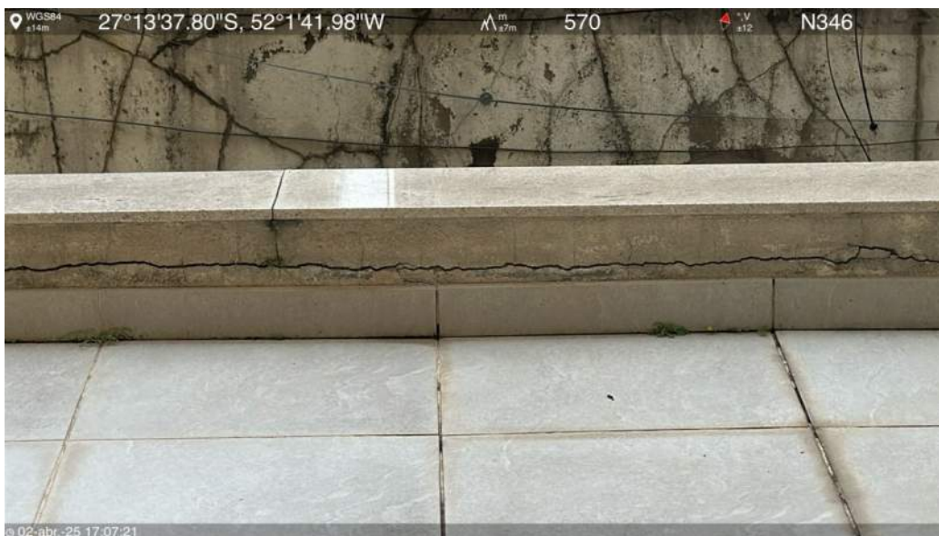
Laje intermediária do 2º pavimento
