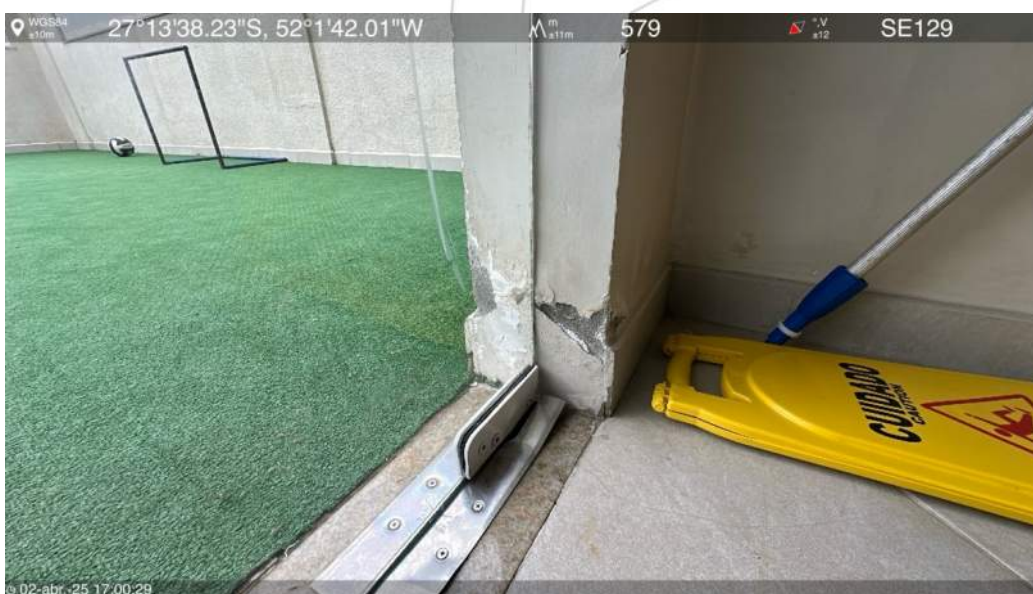
Laje intermediária do 7º pavimento
