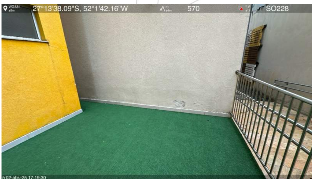
Fachada norte (vão)
