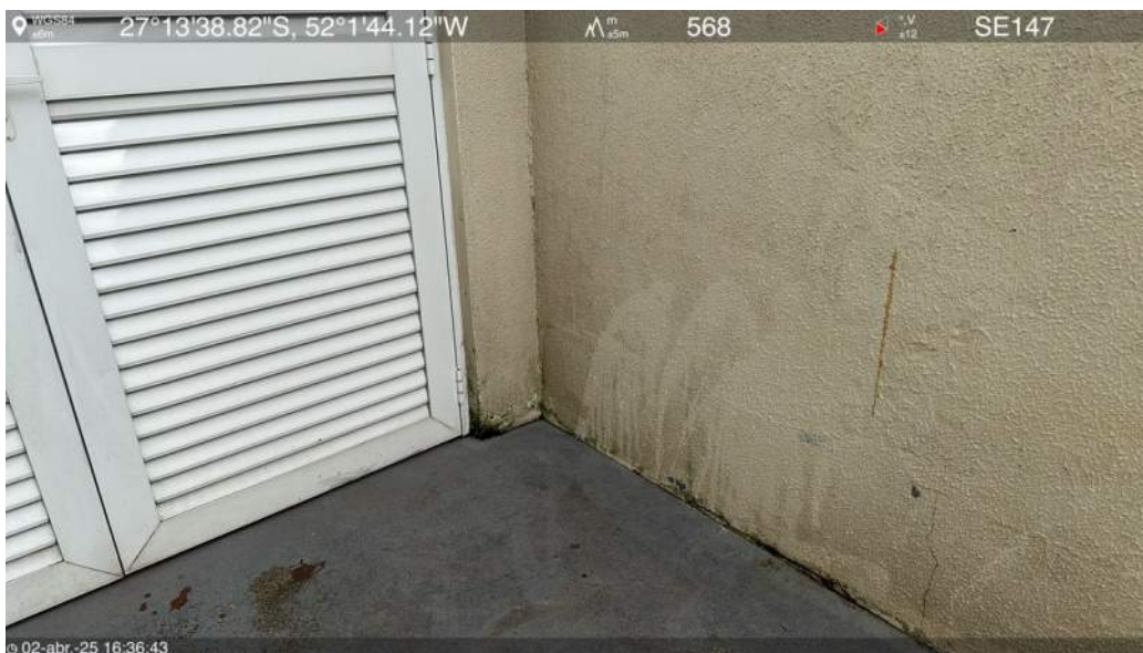
Rampa de acesso oeste
