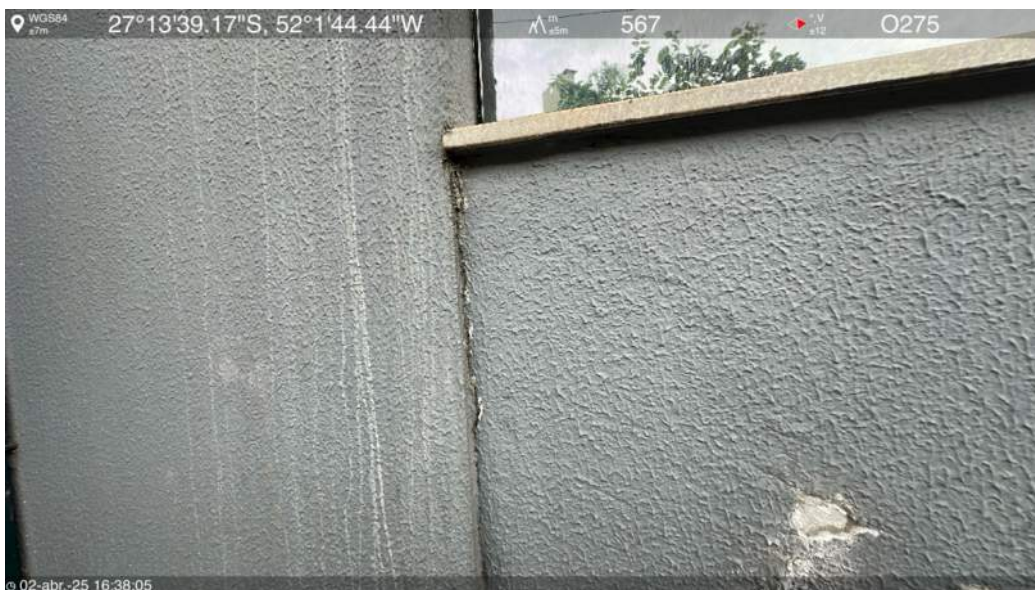
Rampa de acesso oeste
