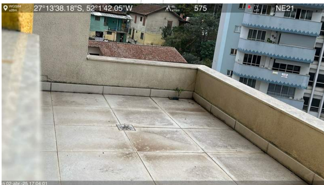
Laje intermediária do 5º pavimento
