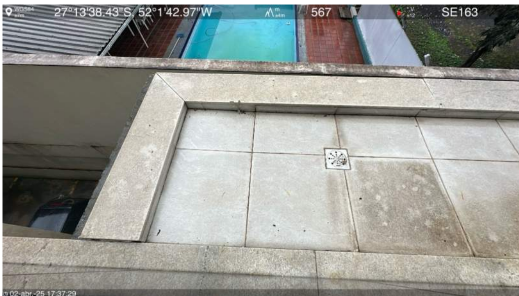
Laje intermediária (Recepção)
