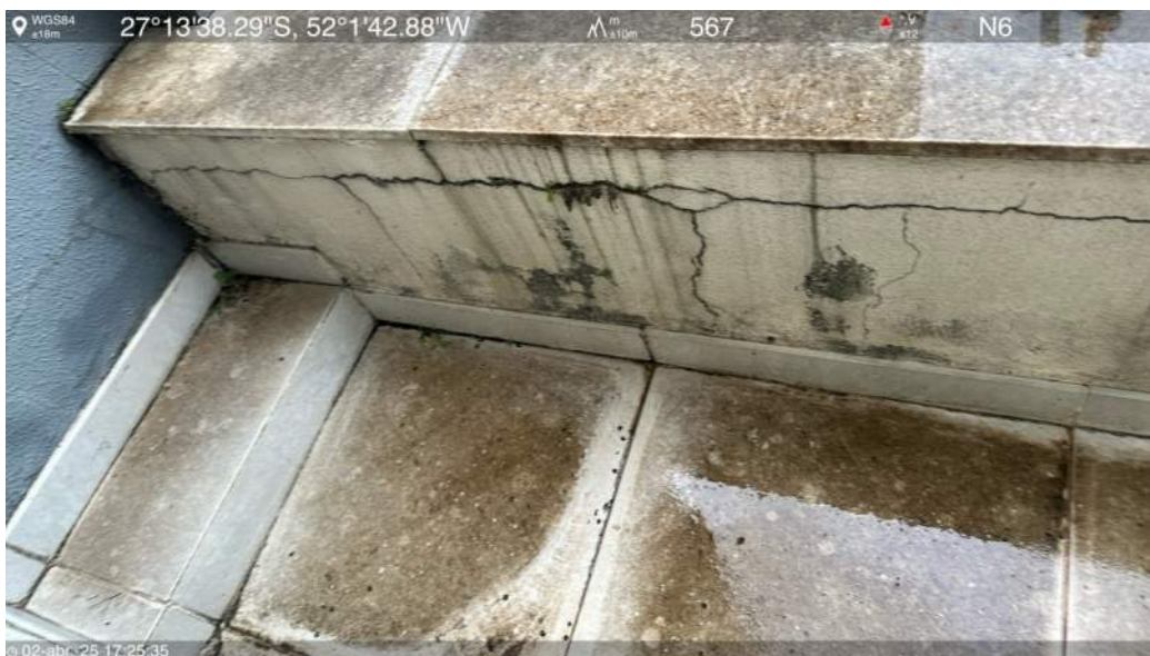
Laje intermediária 2º pavimento (Sala dos Técnicos)
