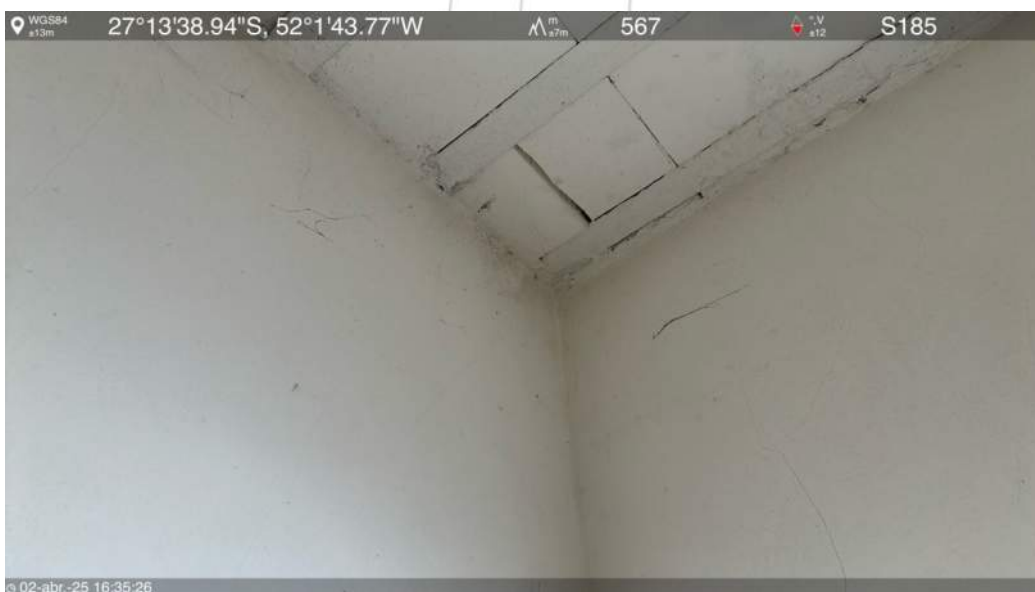
Manutenção (abaixo da laje do 2° pavimento)
