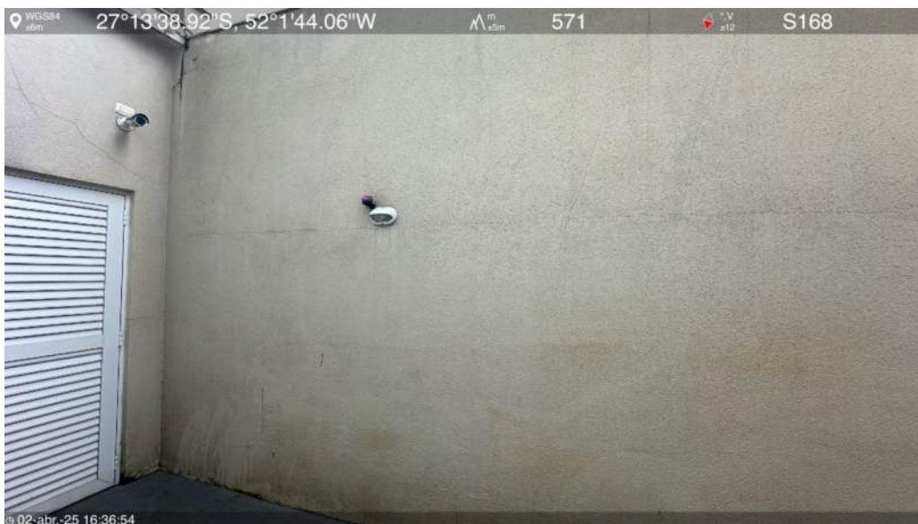
Rampa de acesso oeste
