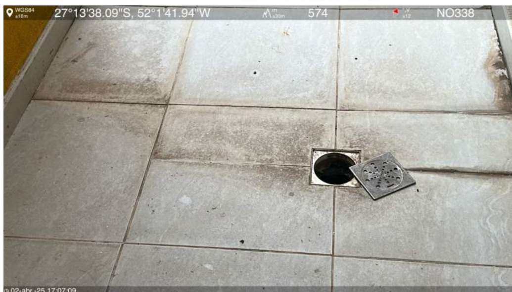
Laje intermediária do 2º pavimento
