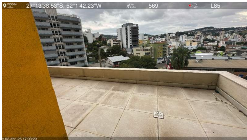
Laje intermediária do 5º pavimento
