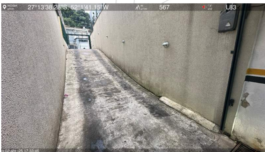
Rampa acesso leste
