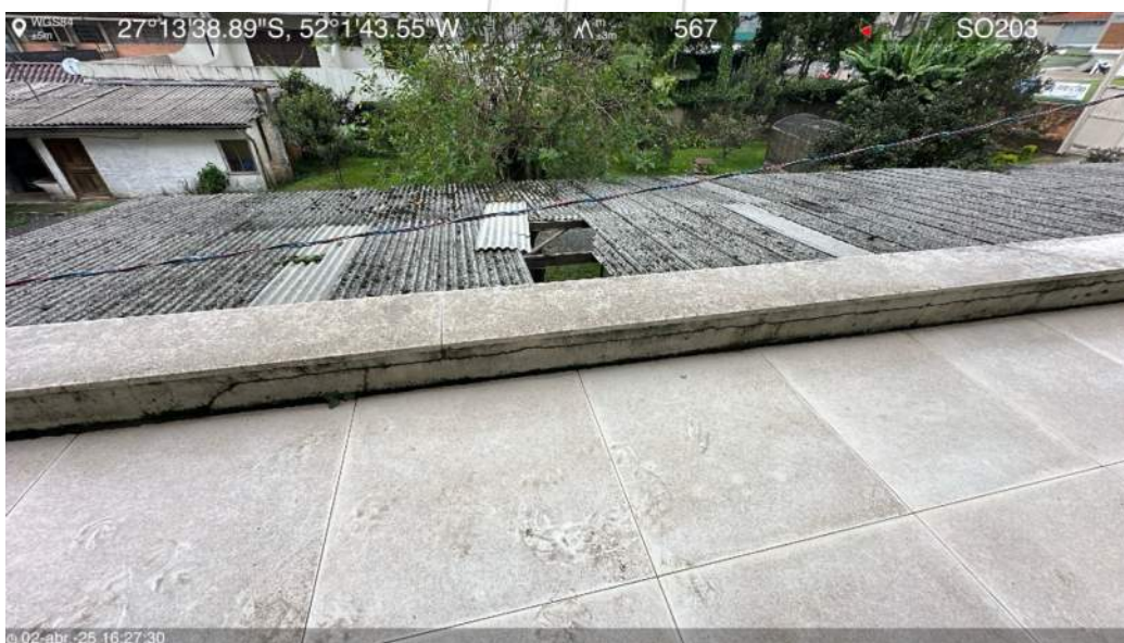
Laje intermediária do 2º pavimento
