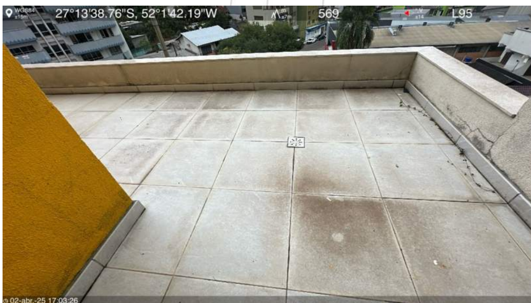
Laje intermediária do 5º pavimento
