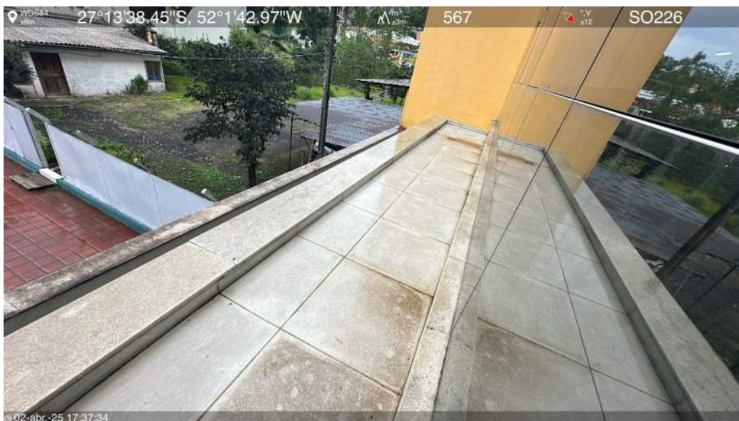
Laje intermediária (Recepção)
