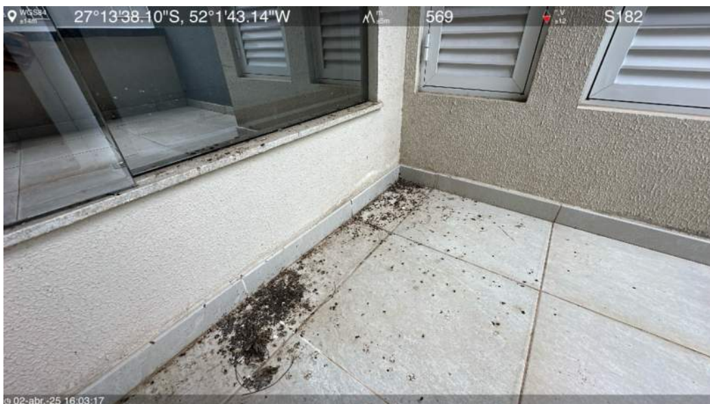
Laje intermediária da biblioteca
