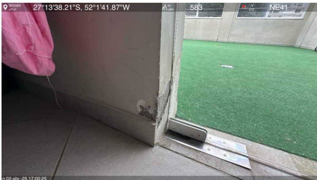
Laje intermediária do 7º pavimento
