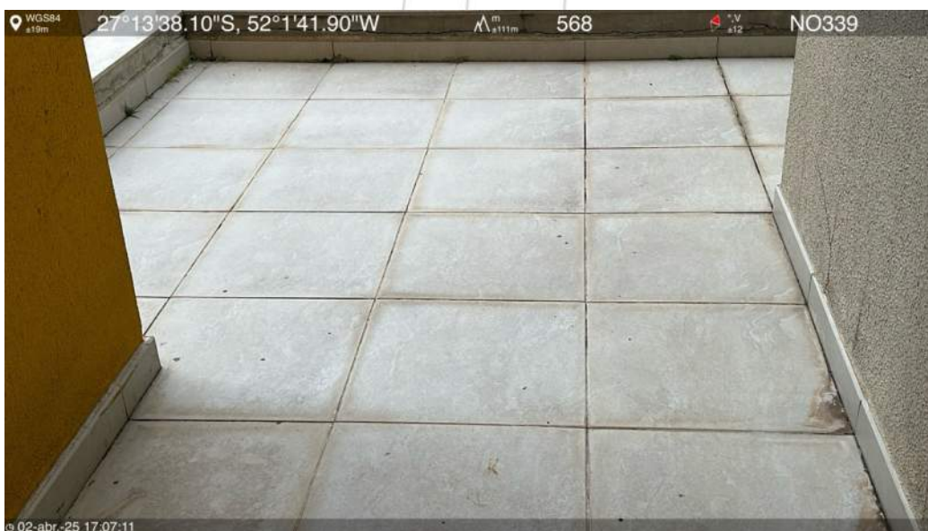
Laje intermediária do 2º pavimento
