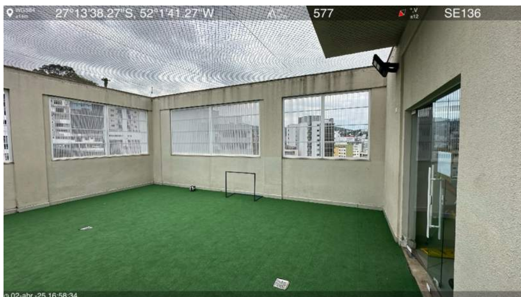
Laje intermediária do 7º pavimento
