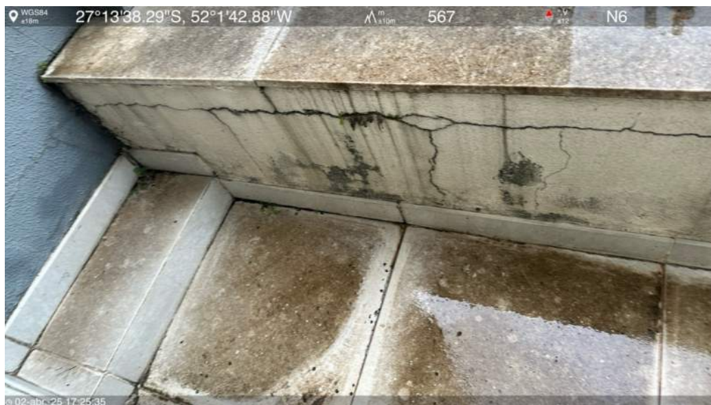
Laje intermediária 2º pavimento (Sala dos Técnicos)
