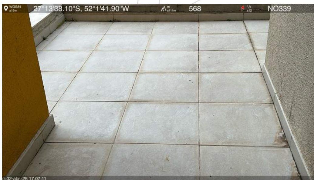
Laje intermediária do 2º pavimento
