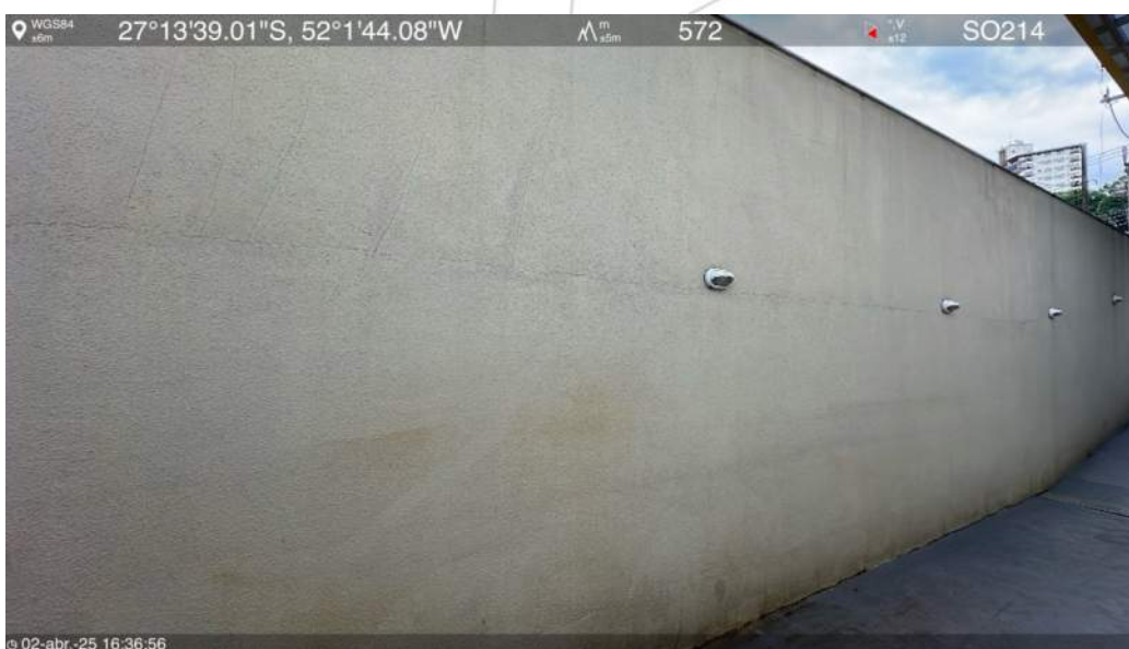
Rampa de acesso oeste
