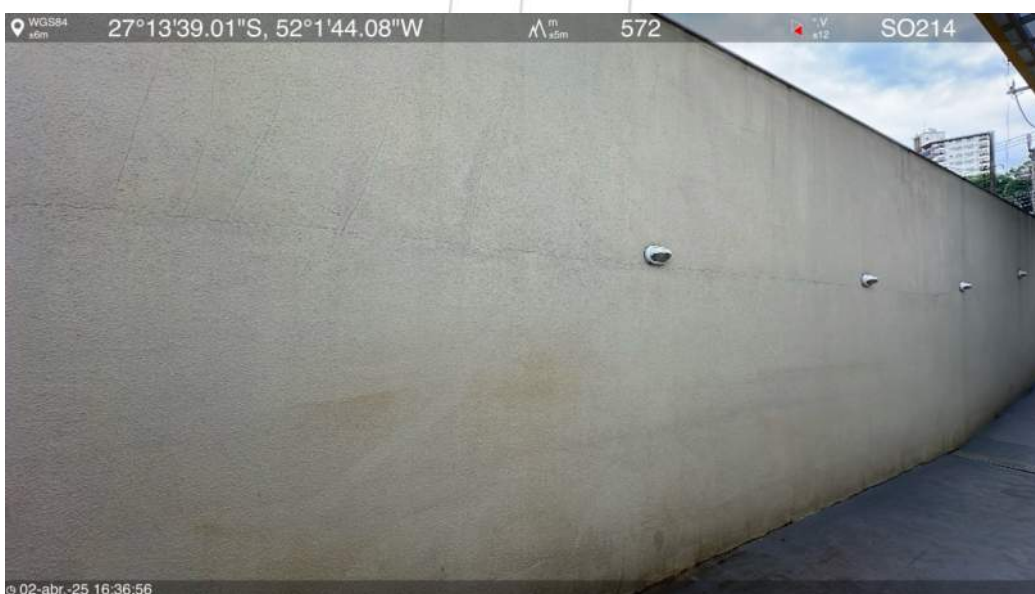
Rampa de acesso oeste
