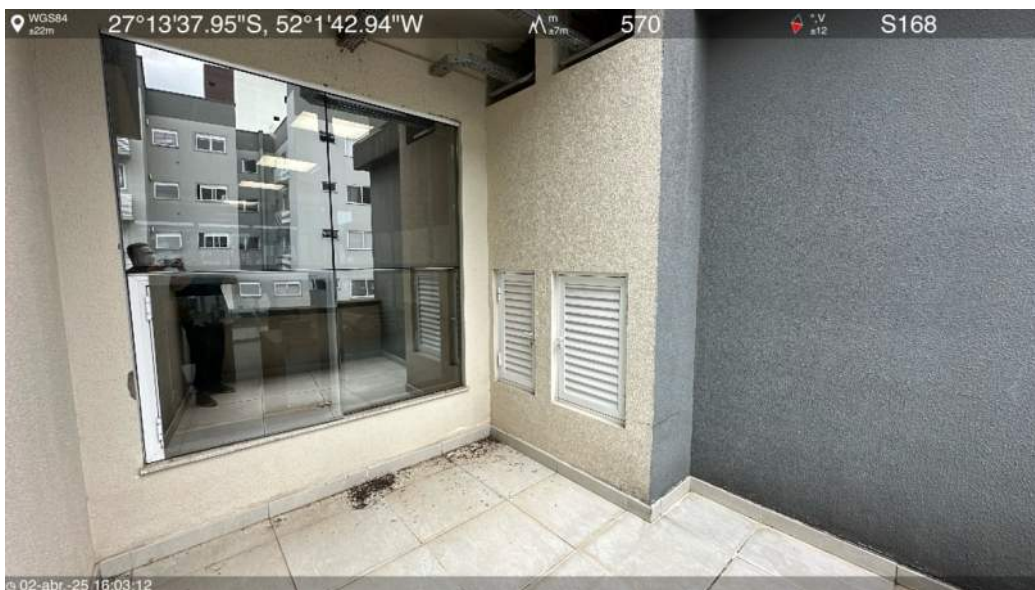
Laje intermediária da biblioteca
