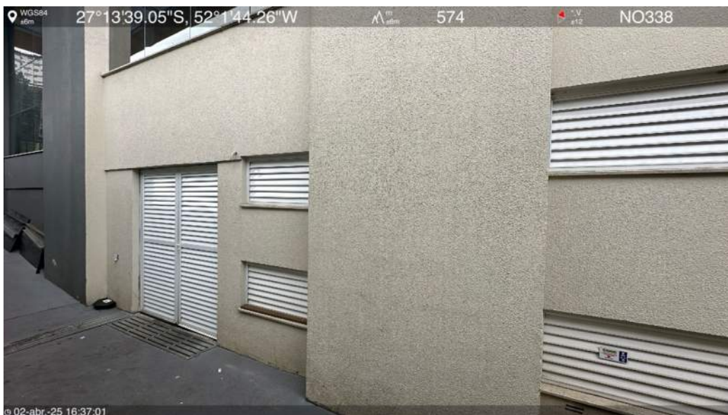
Rampa de acesso oeste
