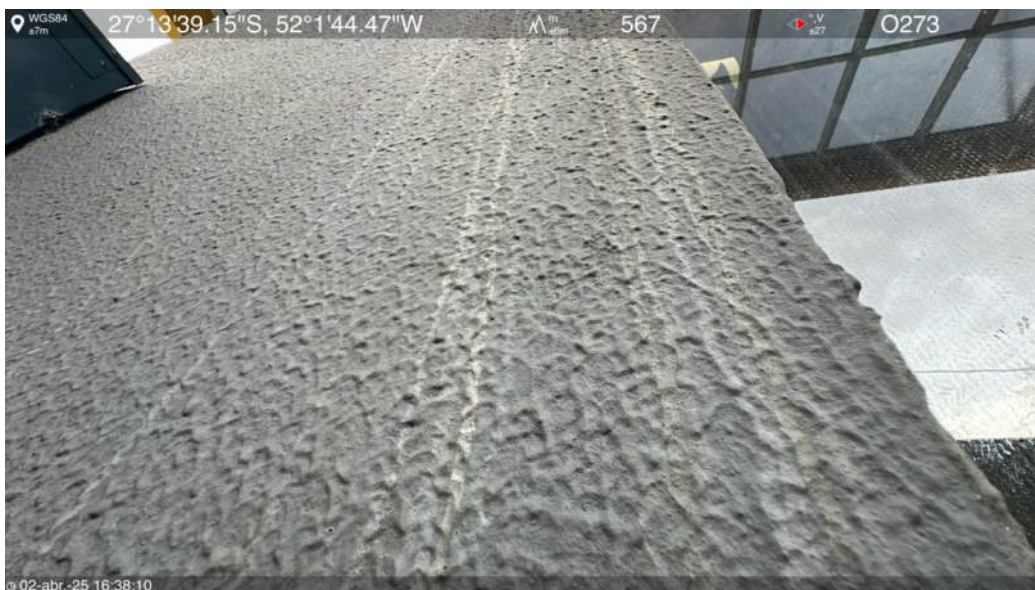
Rampa de acesso oeste
