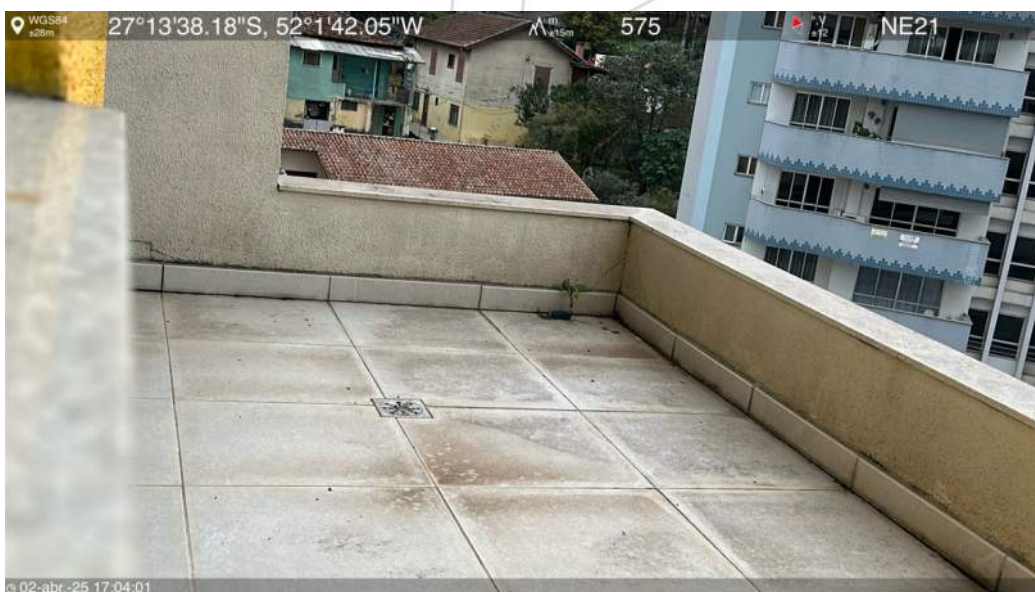
Laje intermediária do 5º pavimento
