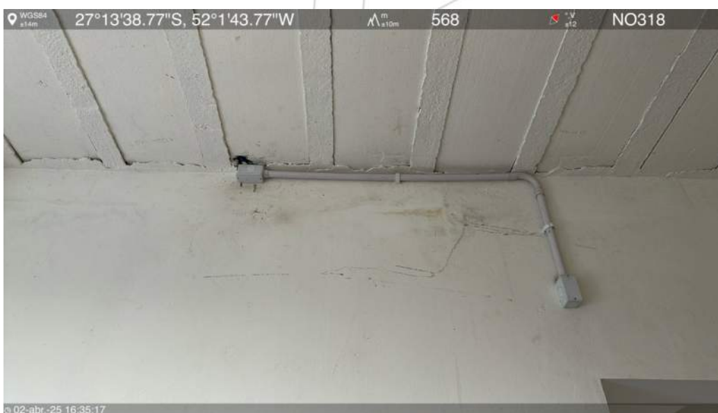
Manutenção (abaixo da laje do 2° pavimento)
