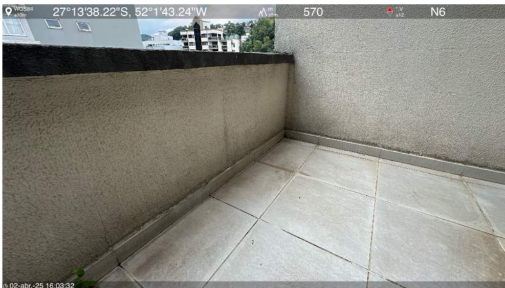
Laje intermediária da biblioteca
