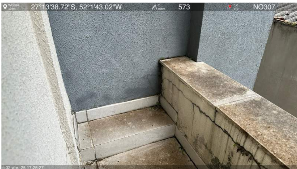
Laje intermediária 2º pavimento (Sala dos Técnicos)
