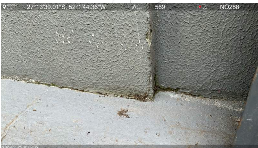
Rampa de acesso oeste
