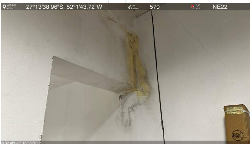
Manutenção (abaixo da laje do 2° pavimento)
