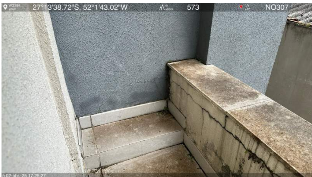
Laje intermediária 2º pavimento (Sala dos Técnicos)
