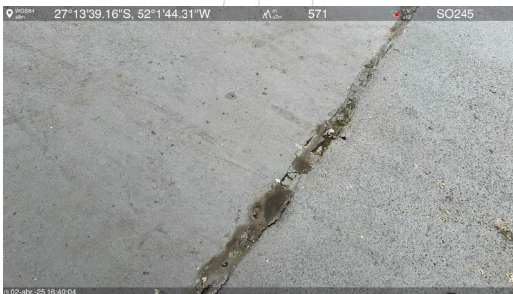
Rampa de acesso oeste
