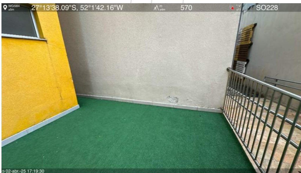
Fachada norte (vão)
