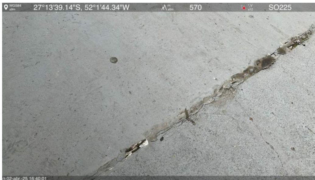
Rampa de acesso oeste
