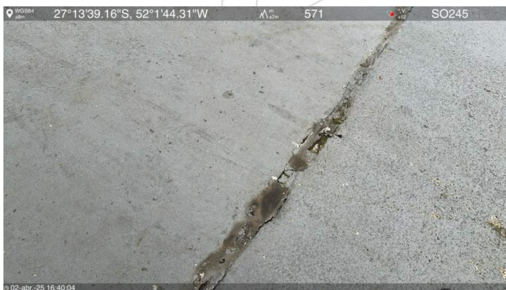
Rampa de acesso oeste
