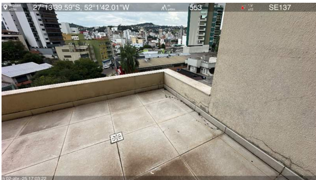
Laje intermediária do 5º pavimento
