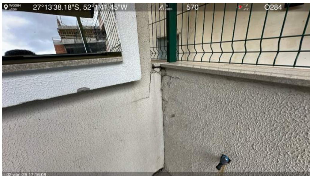
Térreo leste - Parquinho (Detalhe)
