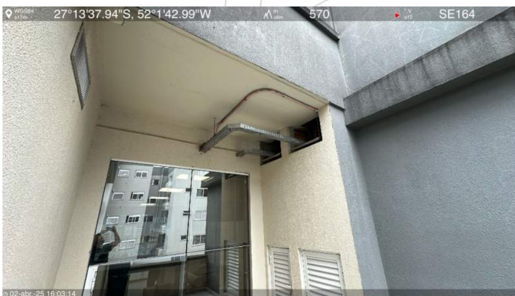
Laje intermediária da biblioteca
