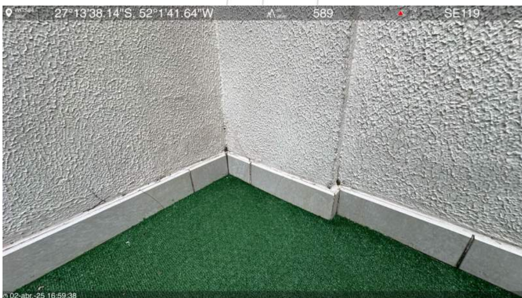
Laje intermediária do 7º pavimento
