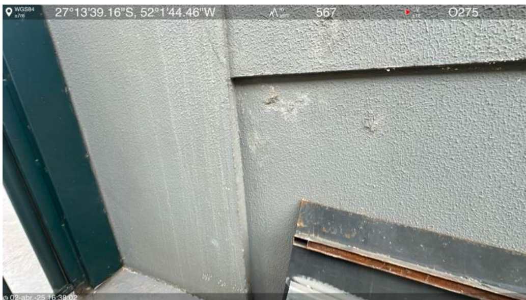
Rampa de acesso oeste
