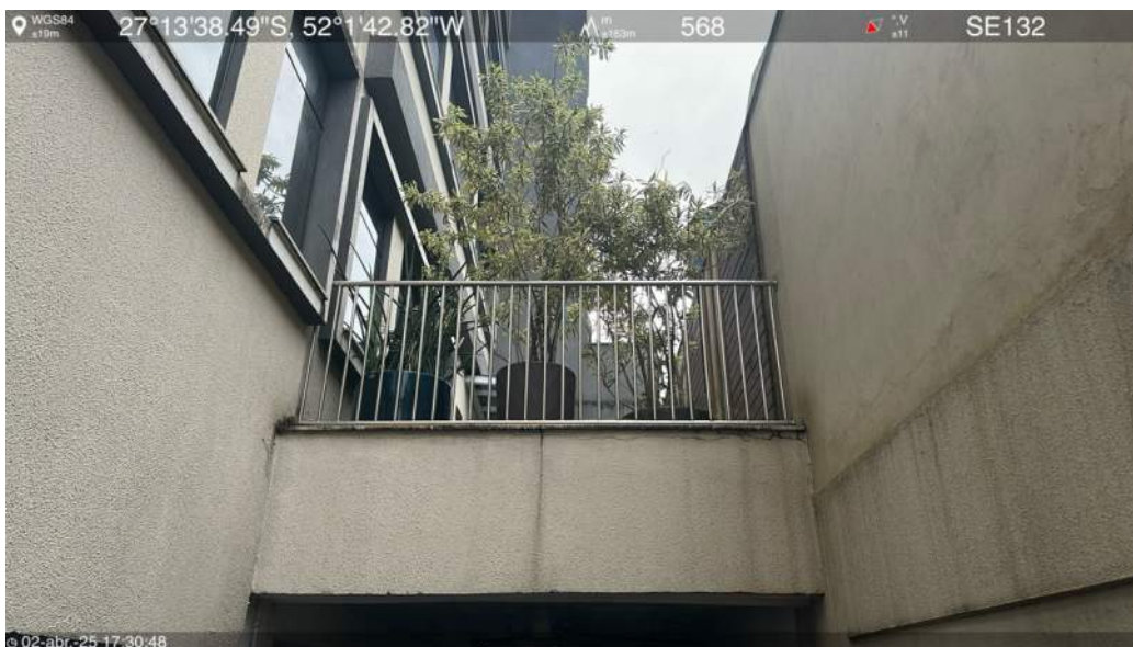
Fachada sul e muros (varanda)
