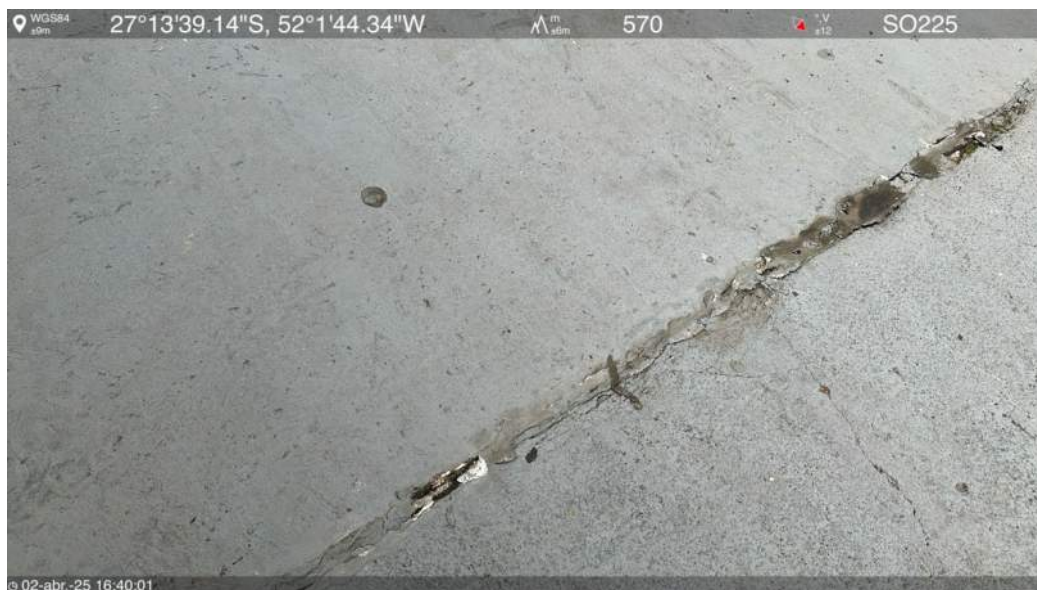
Rampa de acesso oeste
