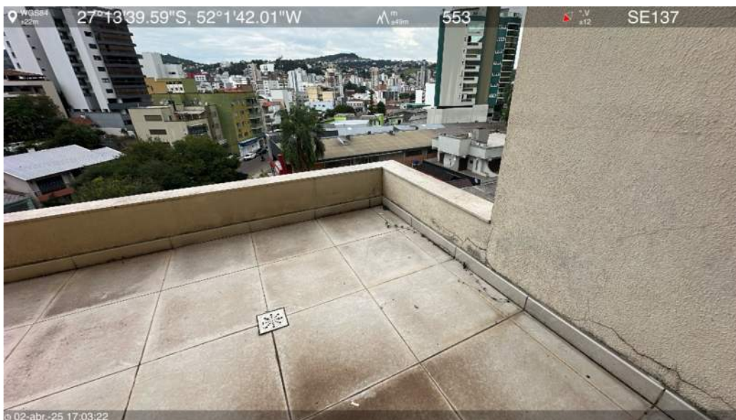
Laje intermediária do 5º pavimento
