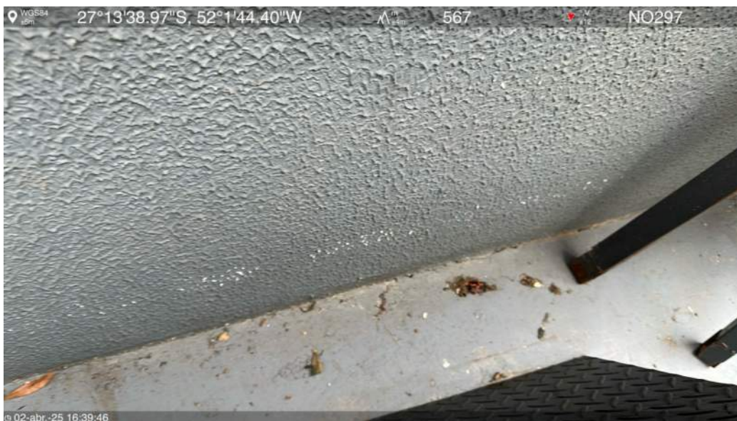
Rampa de acesso oeste
