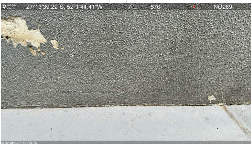
Rampa de acesso oeste
