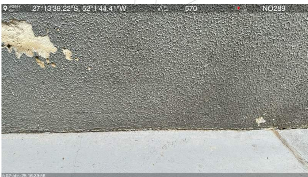
Rampa de acesso oeste
