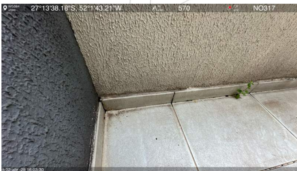
Laje intermediária da biblioteca
