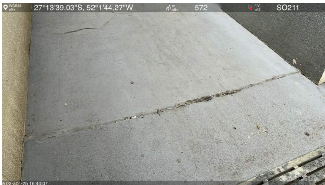
Rampa de acesso oeste
