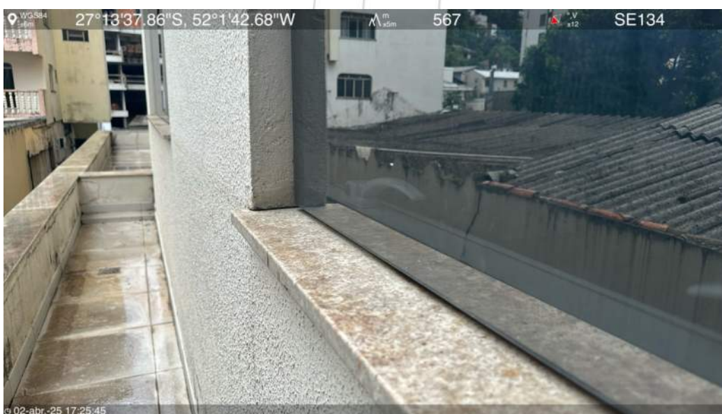
Laje intermediária 2º pavimento (Sala dos Técnicos)
