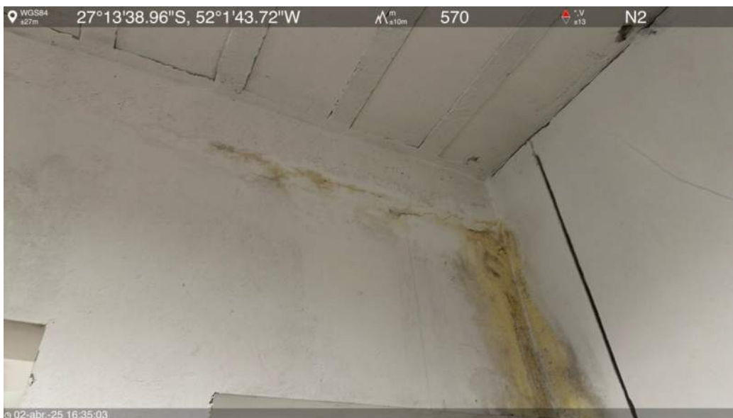
Manutenção (abaixo da laje do 2° pavimento)
