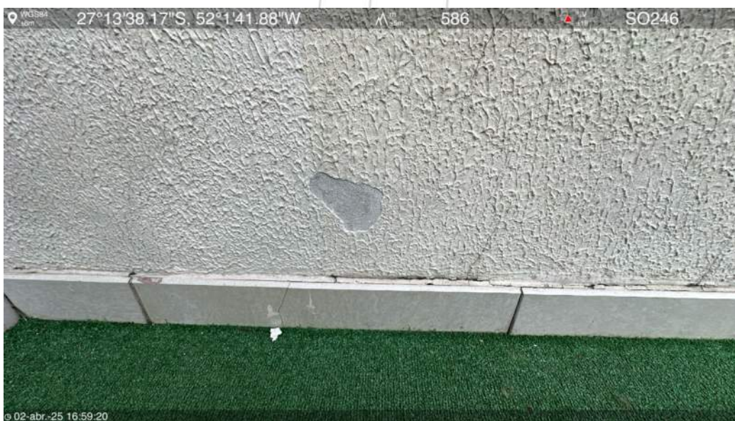
Laje intermediária do 7º pavimento
