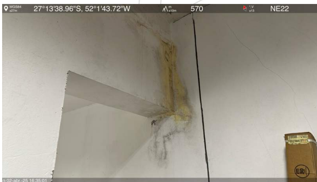
Manutenção (abaixo da laje do 2º pavimento)
