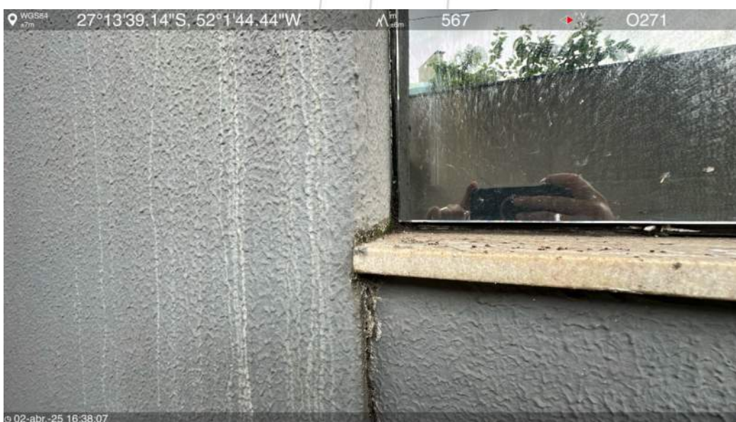
Rampa de acesso oeste
