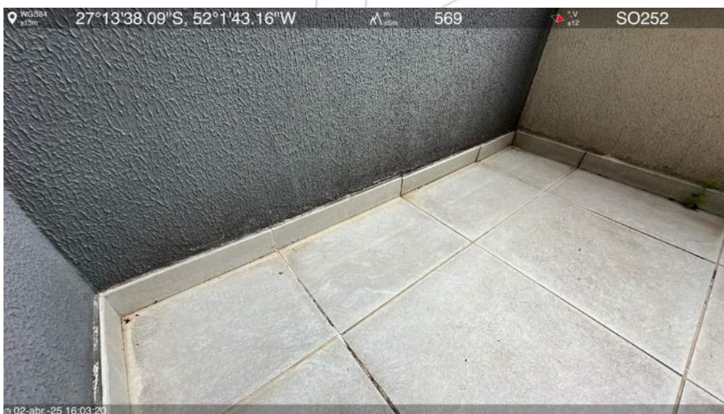
Laje intermediária da biblioteca
