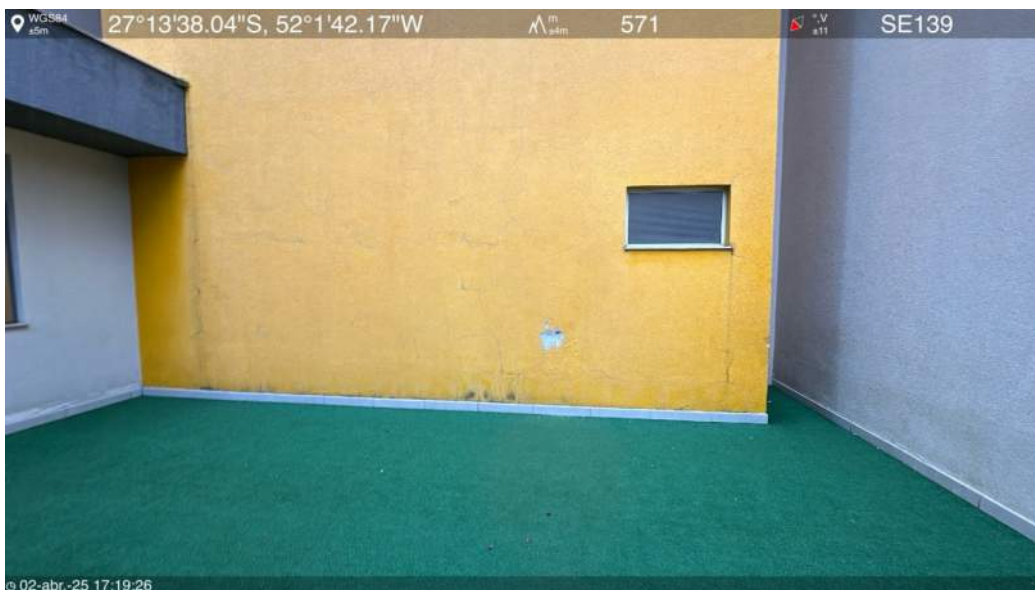
Fachada norte (vão)
