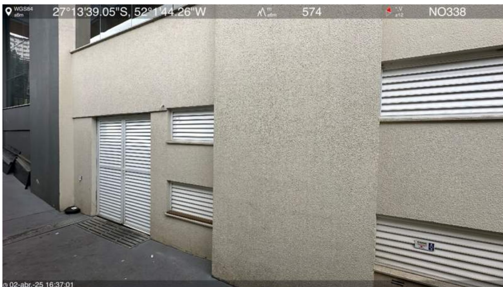
Rampa de acesso oeste
