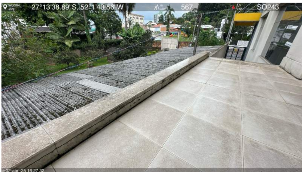
Laje intermediária do 2º pavimento
