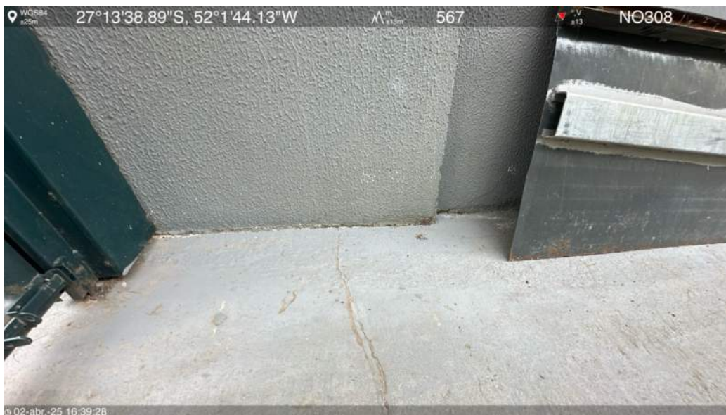
Rampa de acesso oeste
