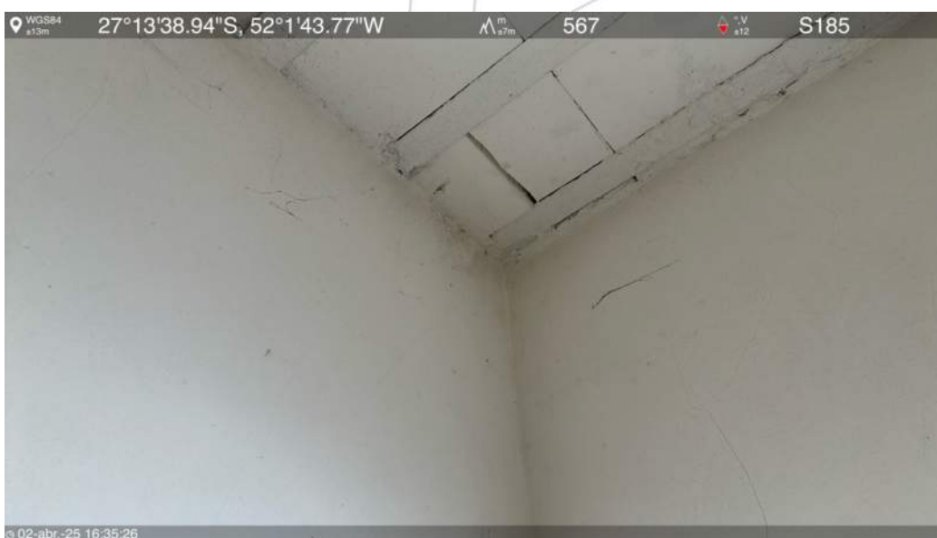
Manutenção (abaixo da laje do 2º pavimento)
