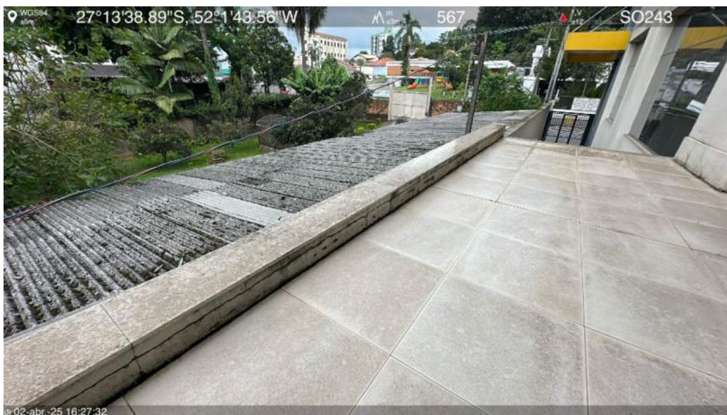
Laje intermediária do 2º pavimento
