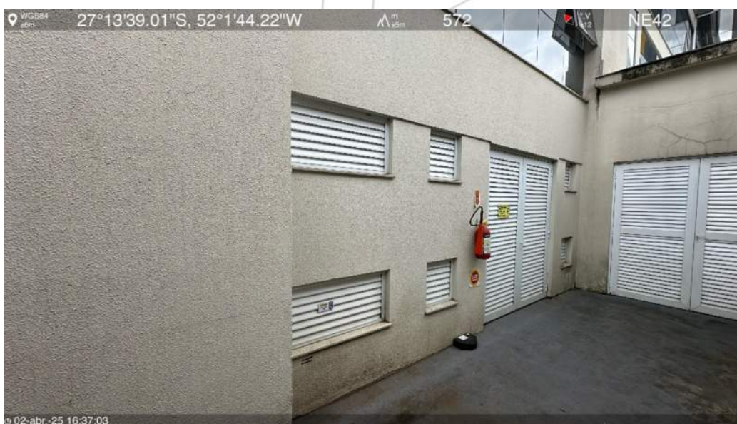
Rampa de acesso oeste
