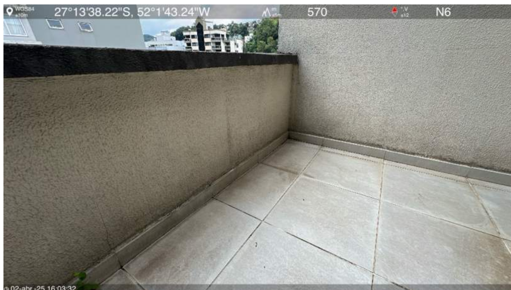
Laje intermediária da biblioteca
