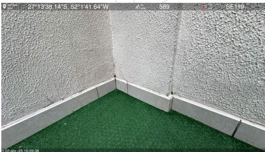
Laje intermediária do 7º pavimento
