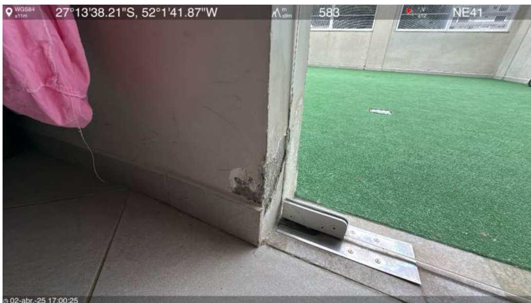
Laje intermediária do 7º pavimento
