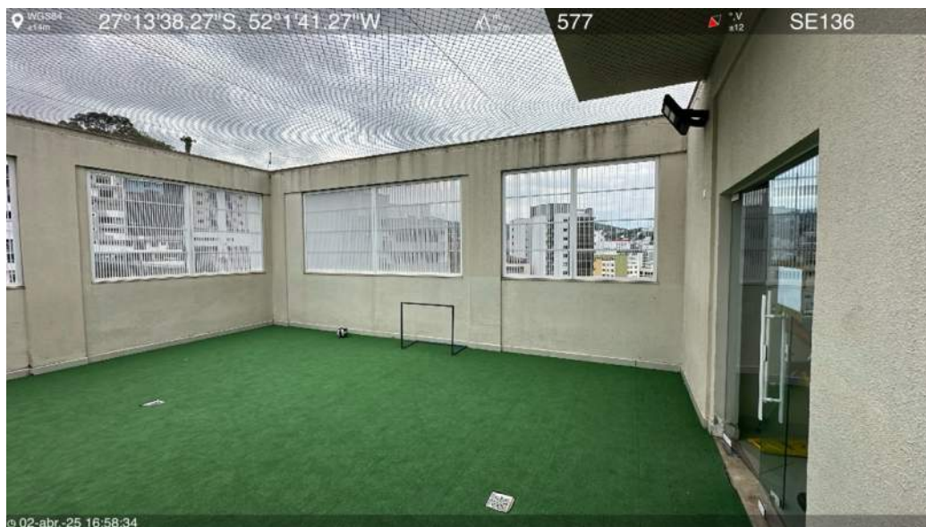
Laje intermediária do 7º pavimento
