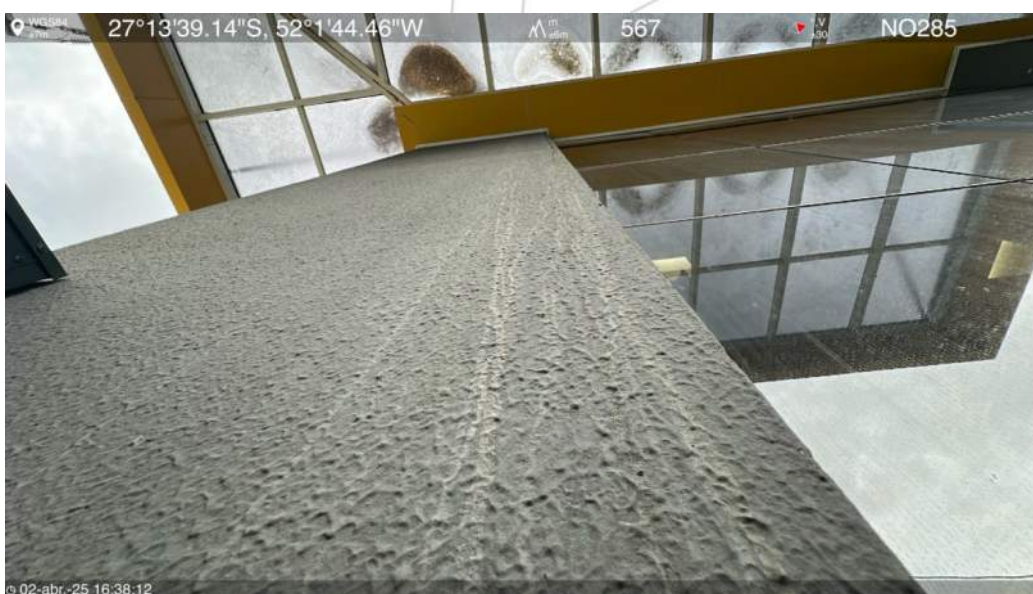
Rampa de acesso oeste
