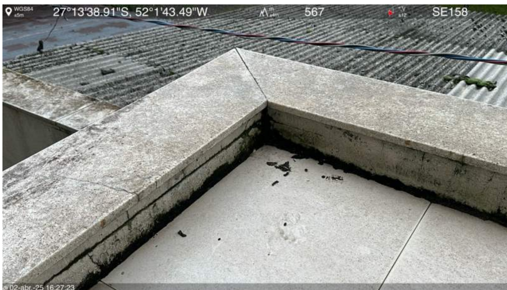
Laje intermediária do 2º pavimento
