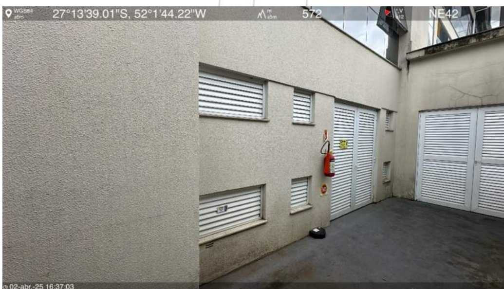
Rampa de acesso oeste
