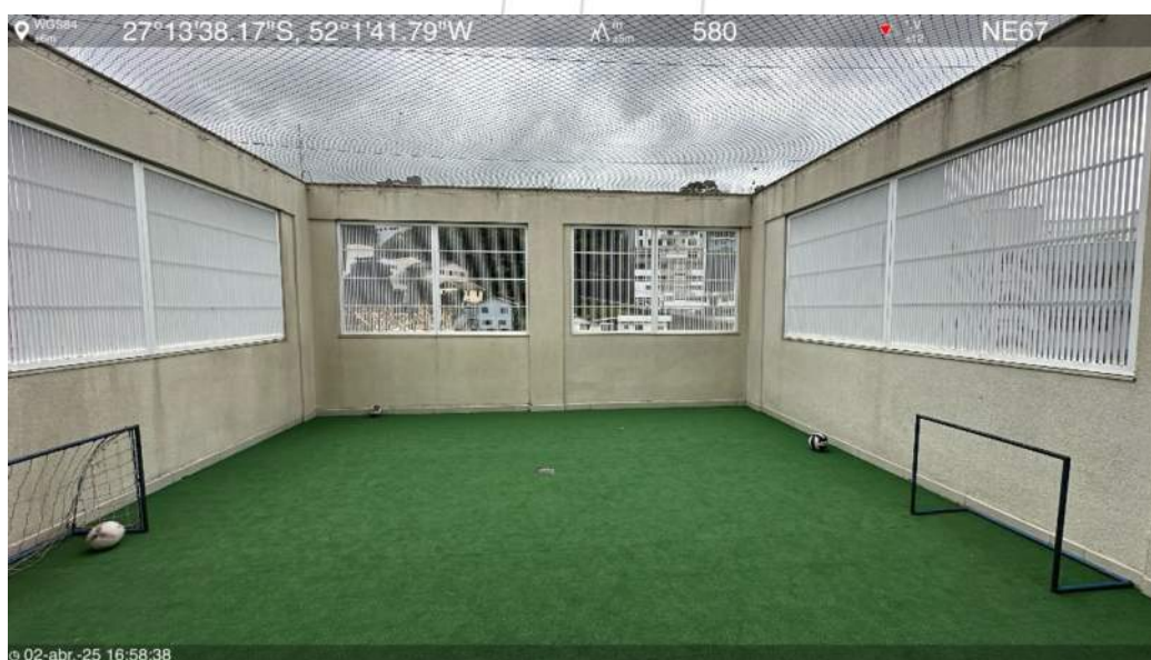
Laje intermediária do 7º pavimento
