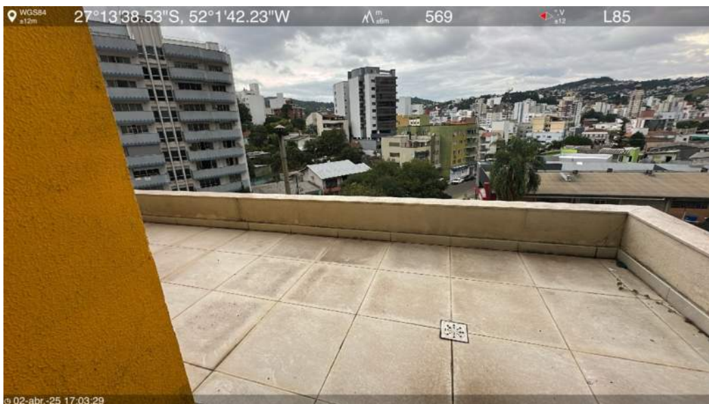
Laje intermediária do 5º pavimento
