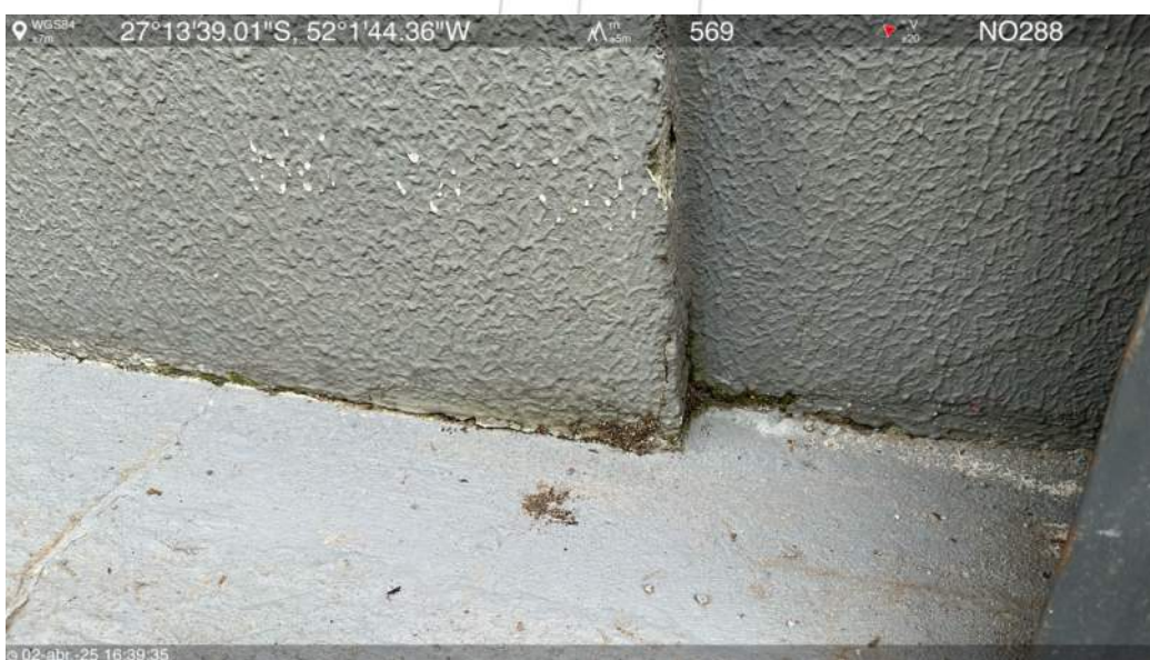
Rampa de acesso oeste
