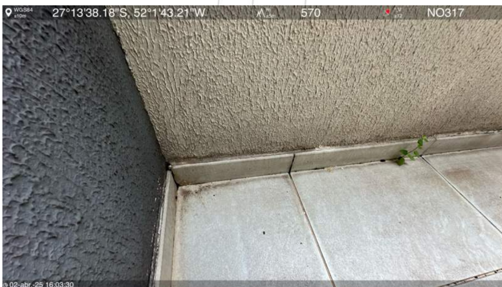
Laje intermediária da biblioteca
