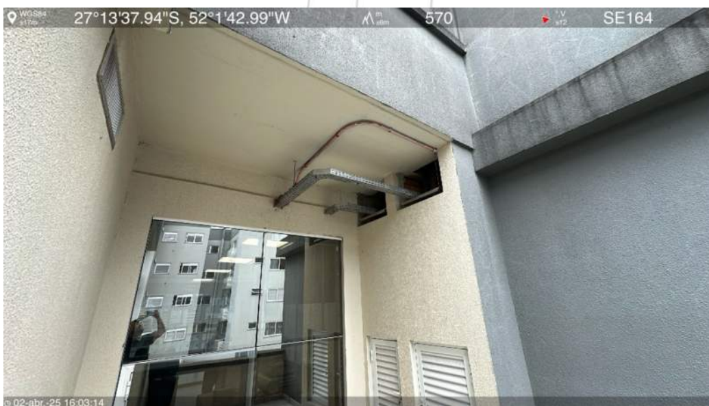
Laje intermediária da biblioteca
