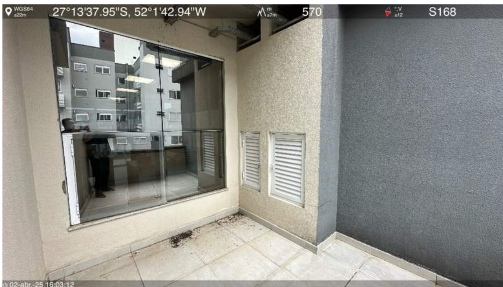
Laje intermediária da biblioteca
