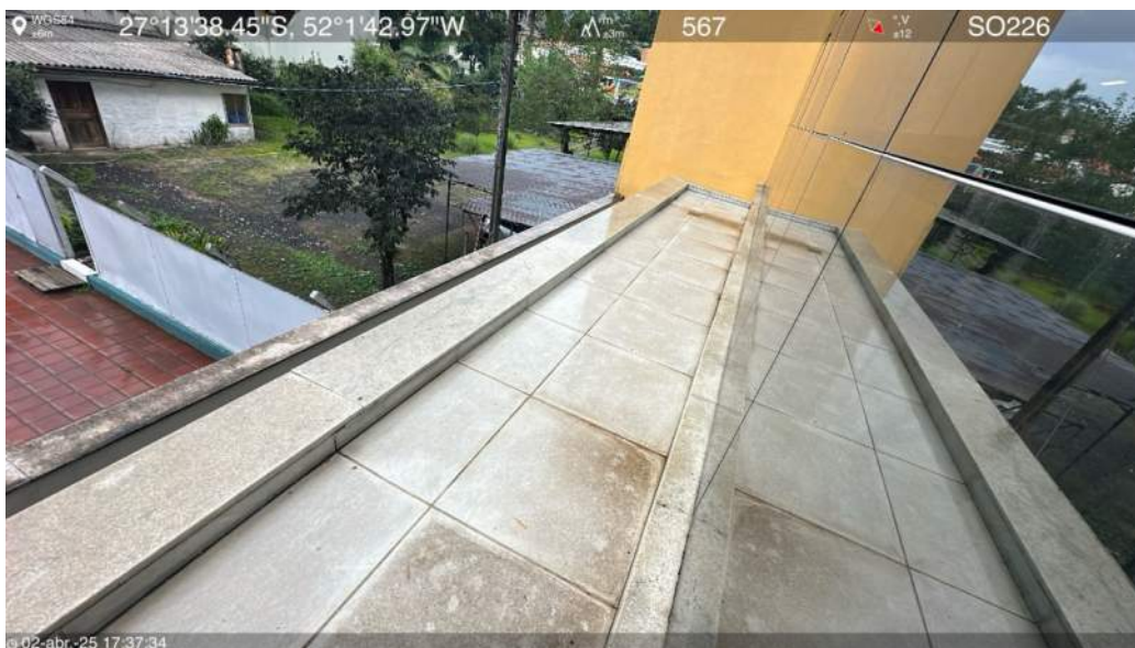
Laje intermediária (Recepção)
