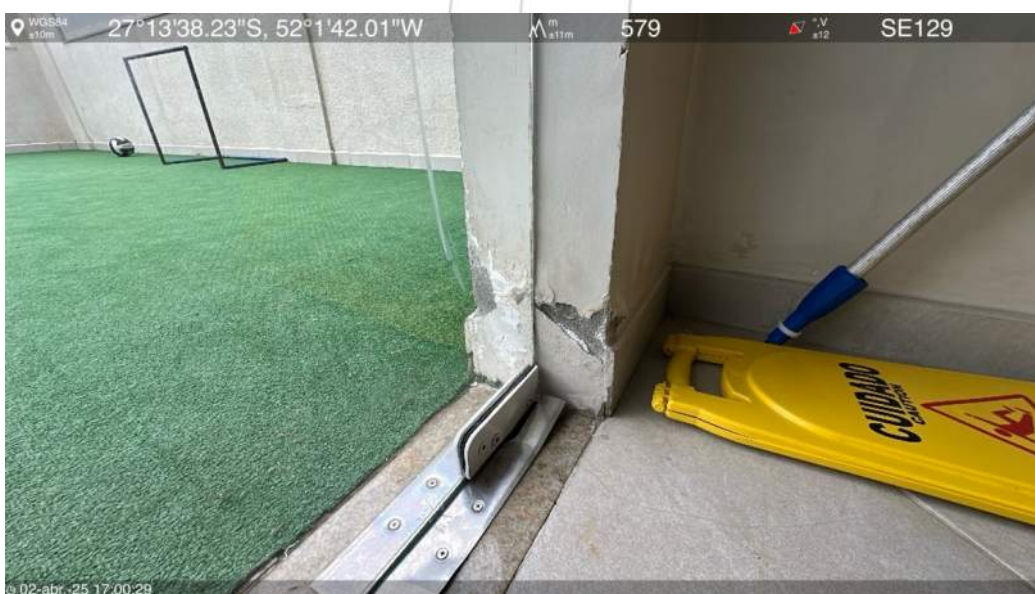
Laje intermediária do 7º pavimento
