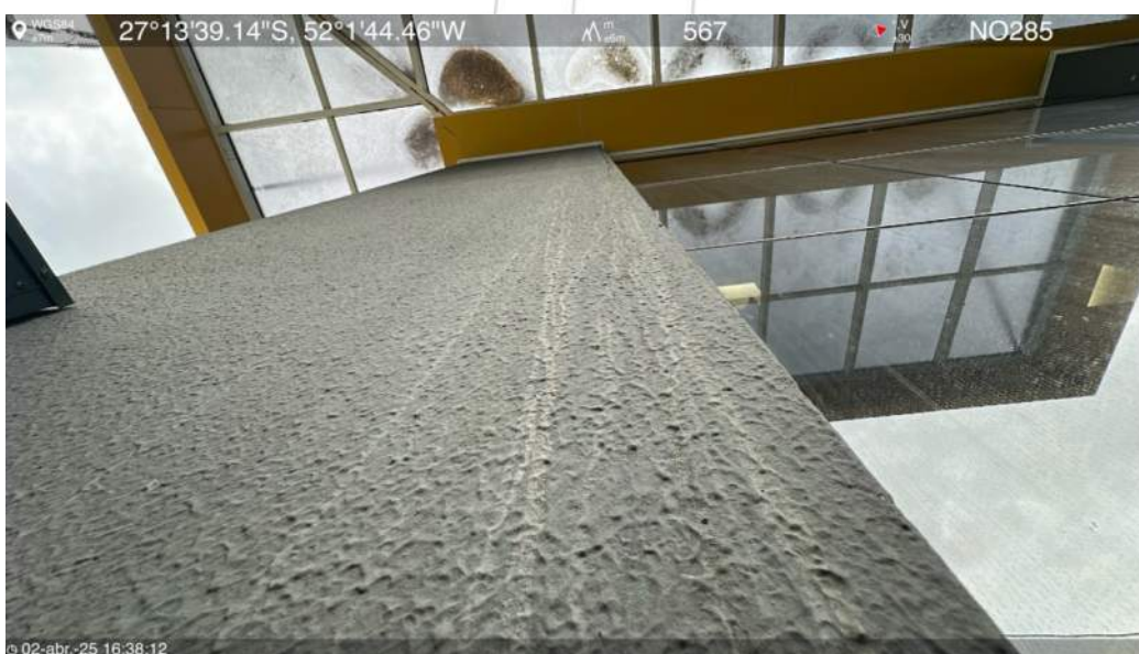
Rampa de acesso oeste
