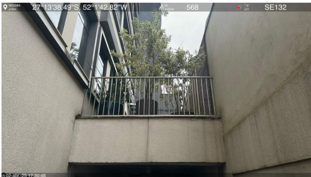
Fachada sul e muros (varanda)
