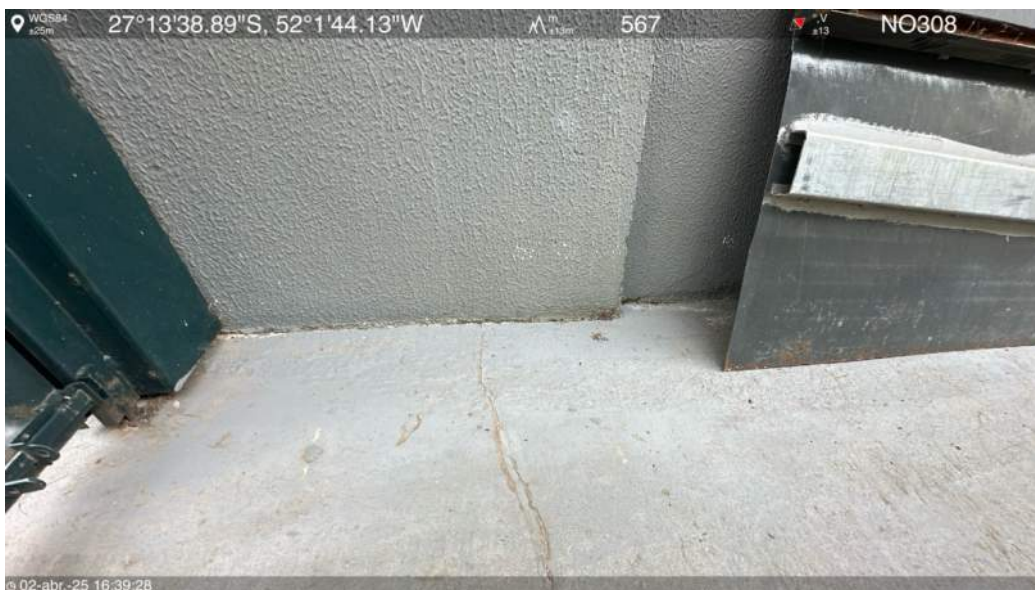
Rampa de acesso oeste
