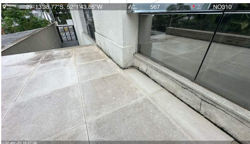
Laje intermediária do 2º pavimento
