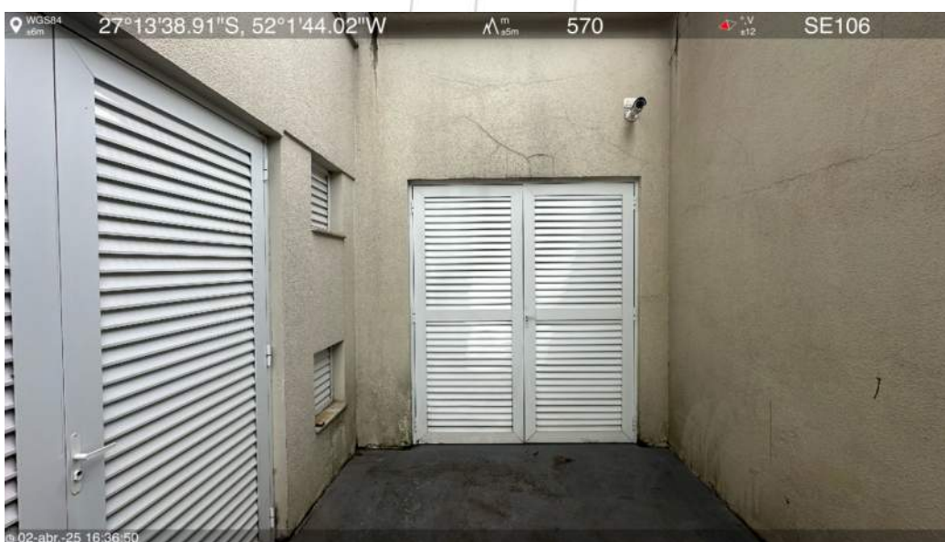
Rampa de acesso oeste
