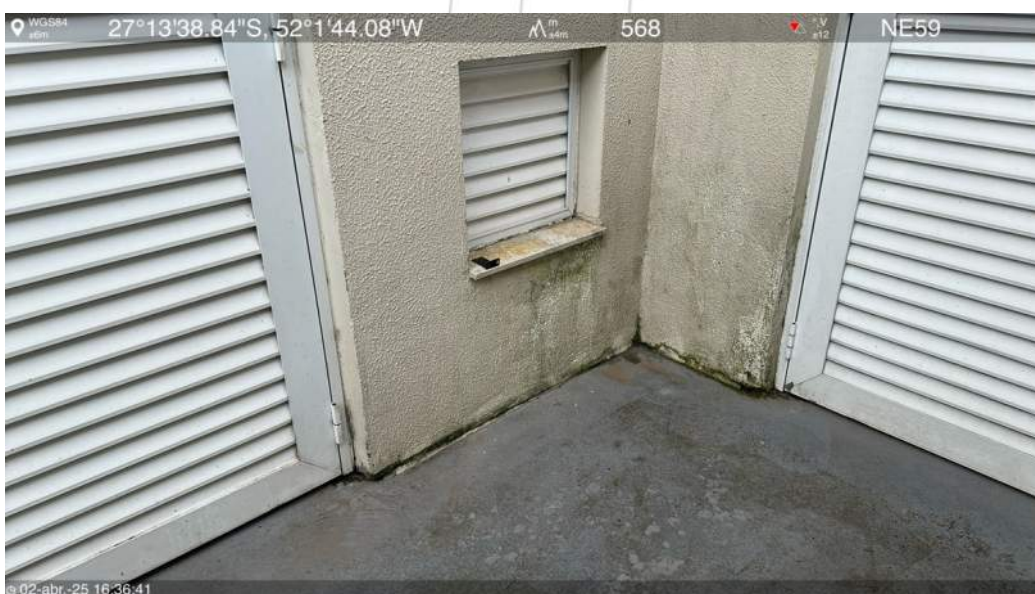
Rampa de acesso oeste
