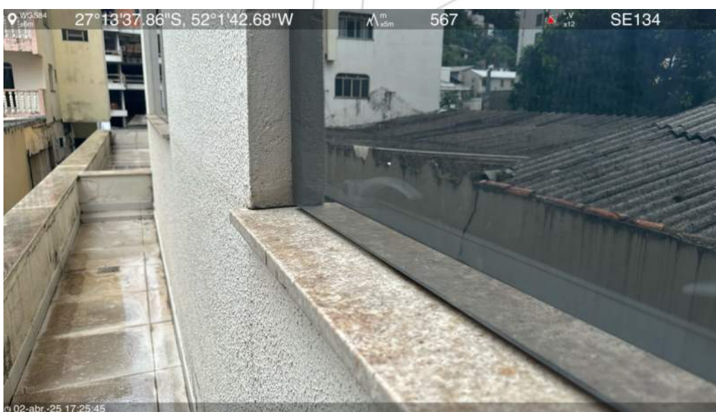
Laje intermediária 2º pavimento (Sala dos Técnicos)
