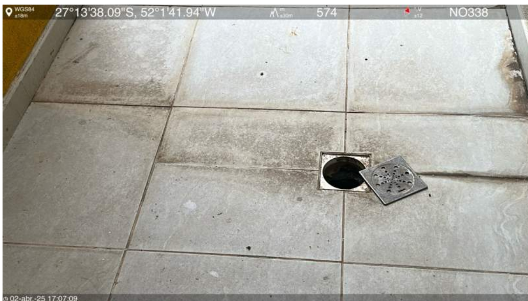
Laje intermediária do 2º pavimento
