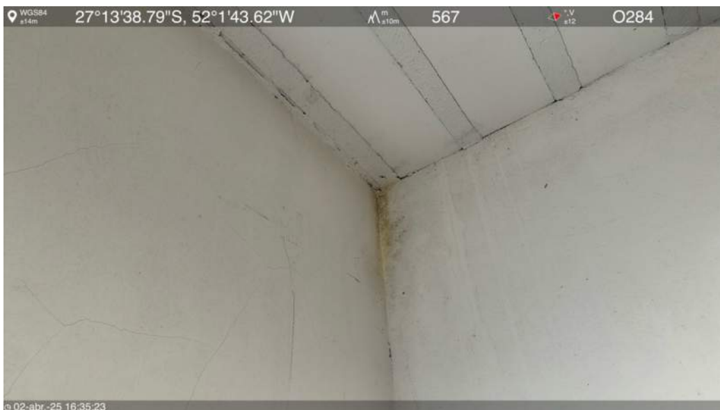
Manutenção (abaixo da laje do 2° pavimento)
