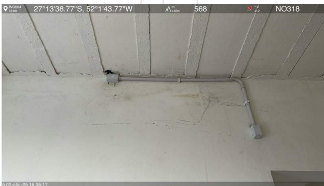
Manutenção (abaixo da laje do 2° pavimento)
