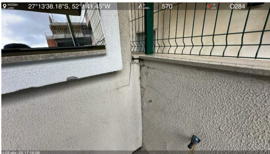
Térreo leste - Parquinho (Detalhe)
