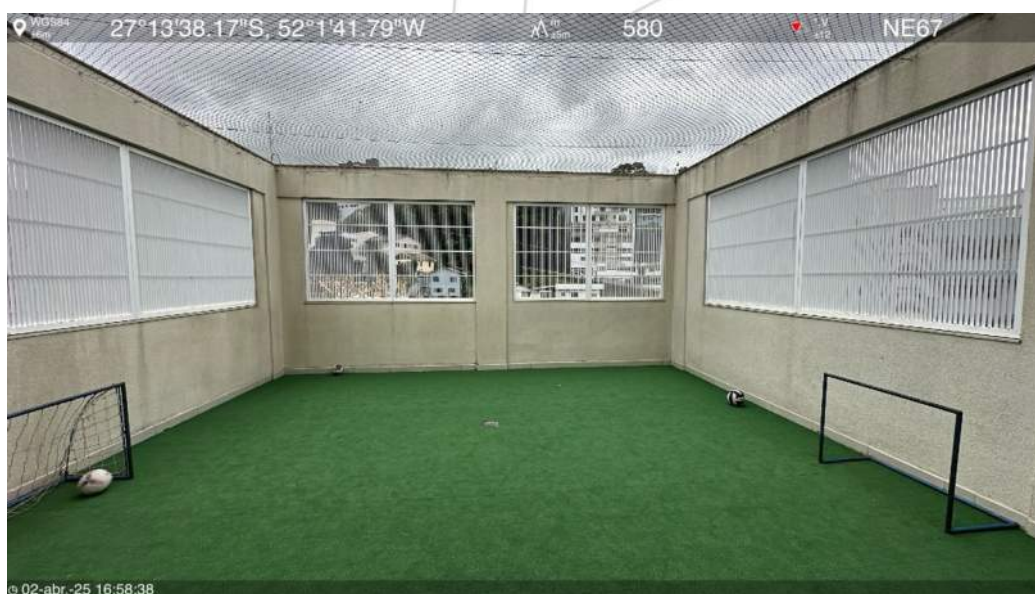
Laje intermediária do 7º pavimento
