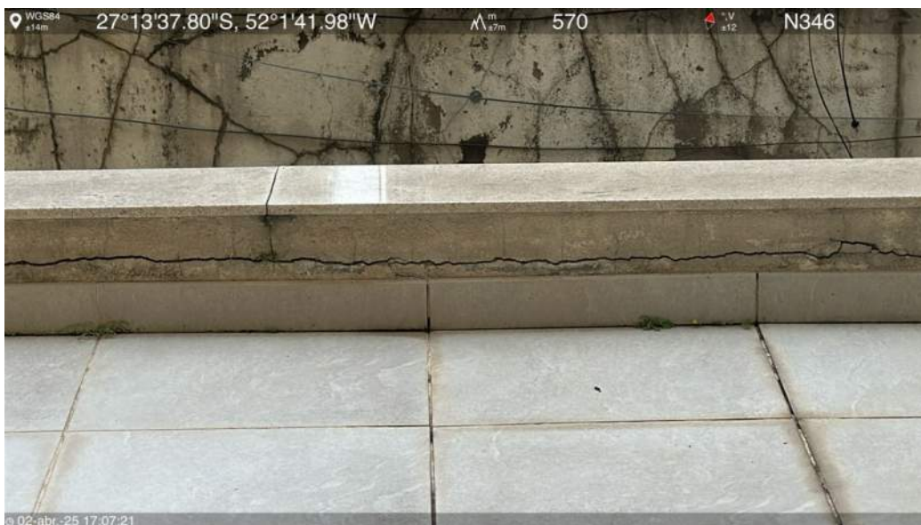
Laje intermediária do 2º pavimento
