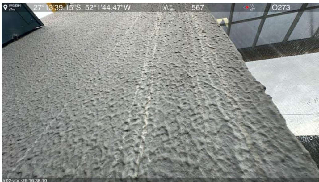
Rampa de acesso oeste
