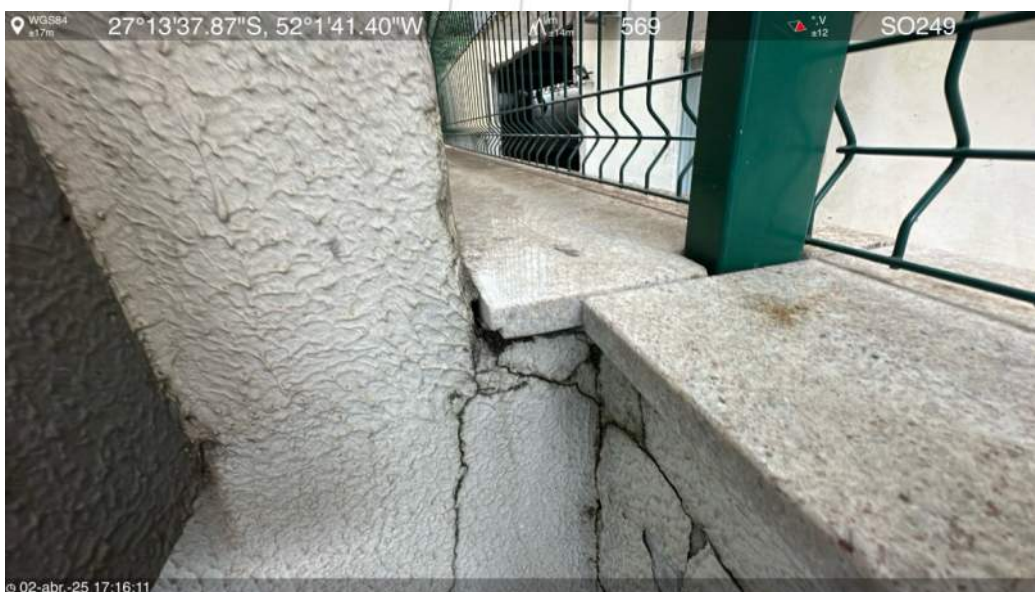
Térreo leste - Parquinho (Detalhe)
