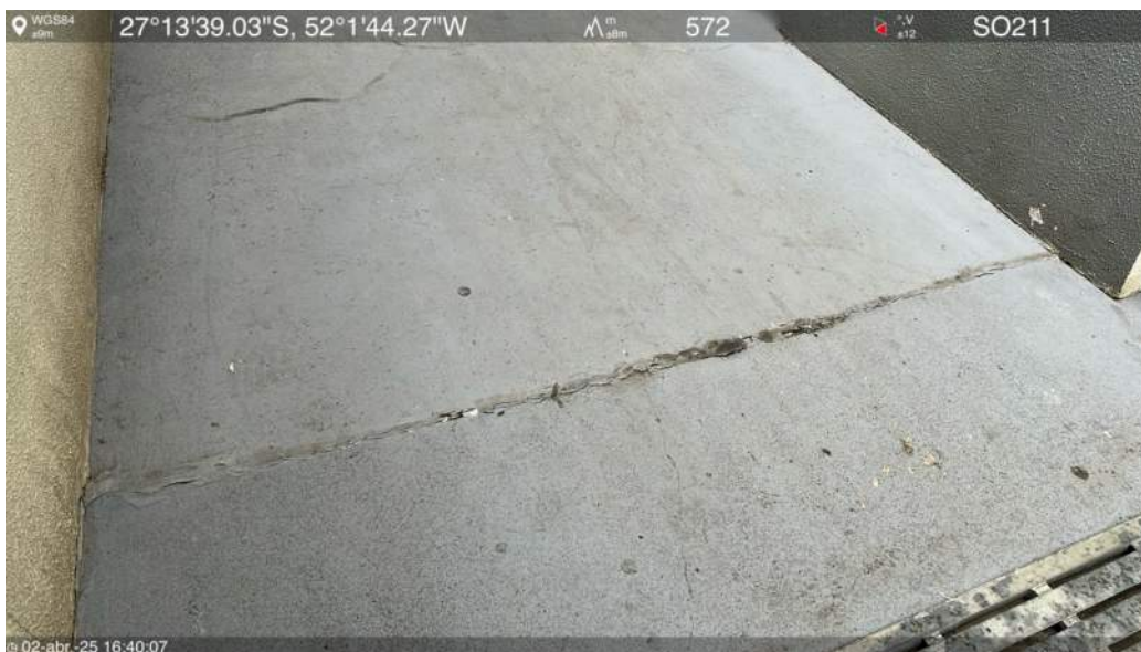
Rampa de acesso oeste
