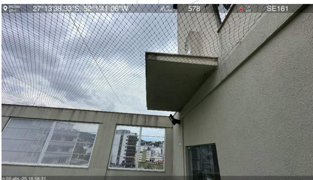
Laje intermediária do 7º pavimento
