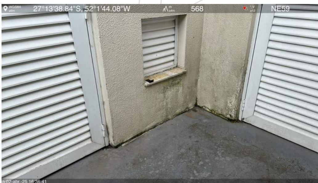
Rampa de acesso oeste
