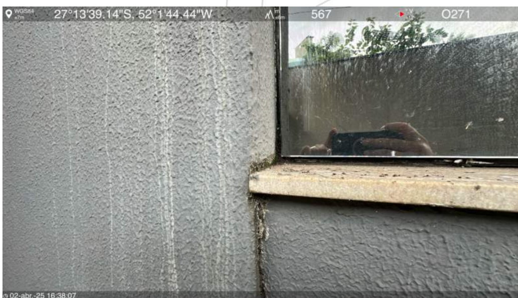
Rampa de acesso oeste
